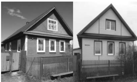
Отремонтированный дом вдовы ветерана ВОВ Лукиной О.Д. (Волховский район, г. Новая Ладога)
