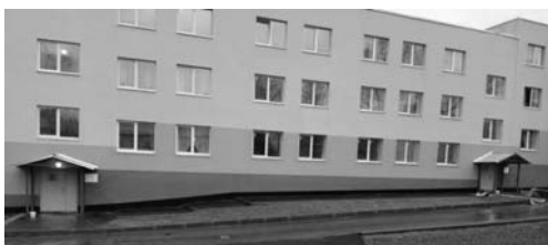
Ремонт фасада (Всеволожский район, д. Рапполово, ул. Овражная, д.28)
