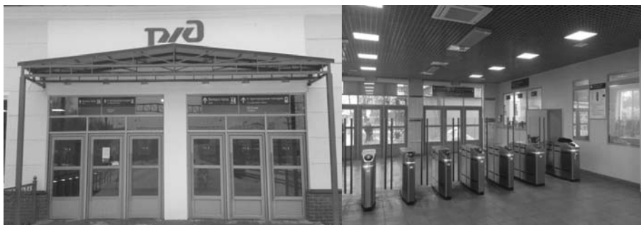
Строительство турникетных павильонов СЗППК
