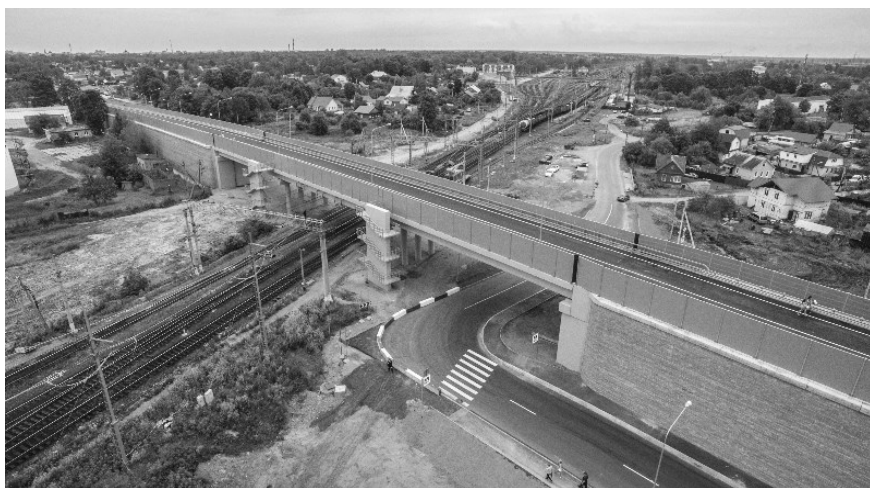
Автоморожный путепровод «Подъезд к г. Гатчина 2».
