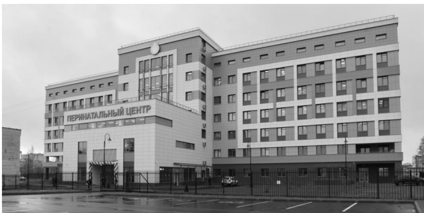
Перинатальный центр в Гатчине.
