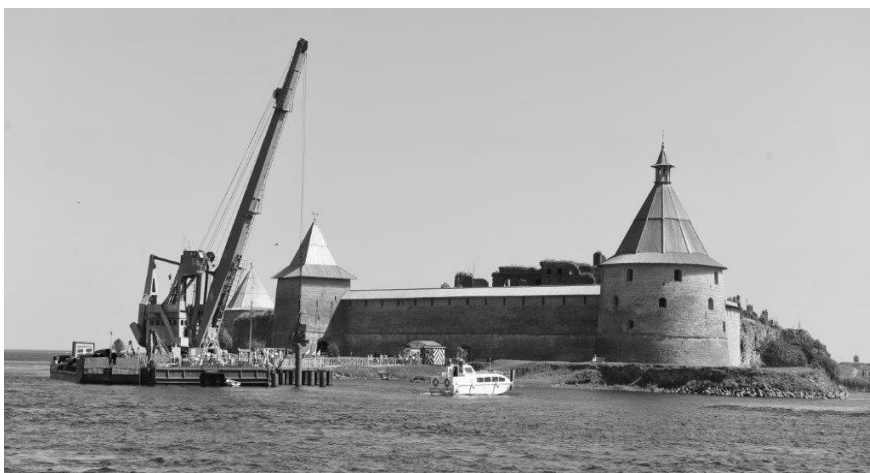
Строительство причала у крепости Орешек.
