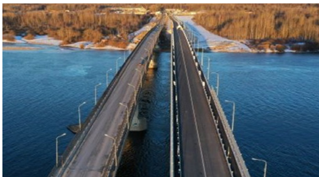
Мост через реку Волхов в Киришах
