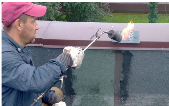
Устранение протечек кровли МКД в Волхове по ул. Профсоюзов д. 10А
