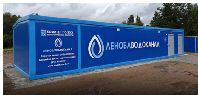
Станция водоподготовки д. Красноозерное (производительность установки составит 500 м³/сутки)
