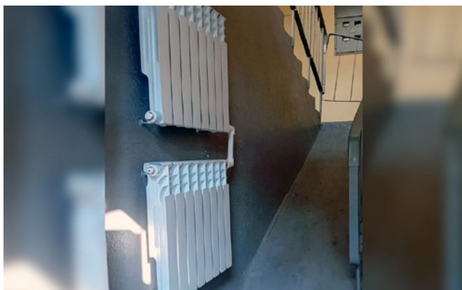
Модернизация отопления в подъезде МКД в г. п. Ульяновка Тосненского района по пр. Володарского, д. 135
