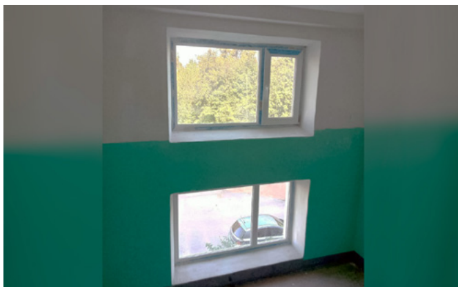
Ремонт подъезда и замена оконных блоков в МКД в Гатчине по ул. Роцинская, д. 21
