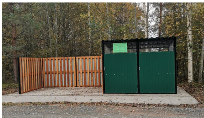
Площадка накопления ТКО в Подпорожском районе
