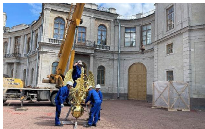
Подготовка к монтажу трехглавого орла (Музей-заповедник «Гатчина»)
