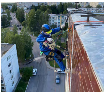
Герметизация швов стеновых панелей МКД в Выборге, ул. Гагарина д. 45
