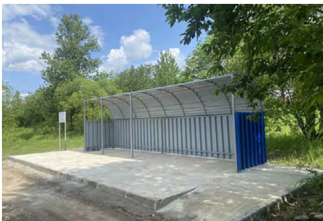
Площадка накопления ТКО в Волховском районе
