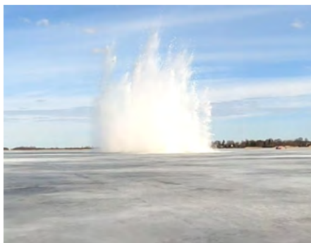
Ледовзрывные работы, мониторинг ледовой обстановки
