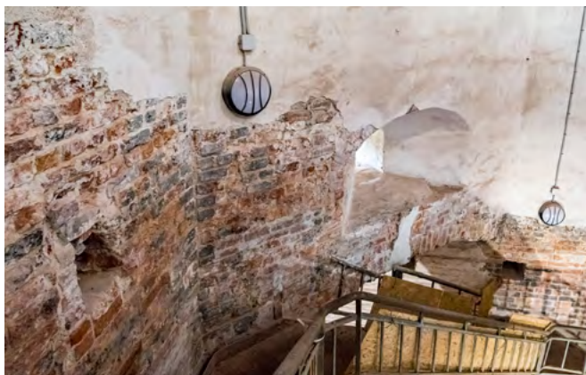
Башня Олафа Выборгского замка до производства работ
