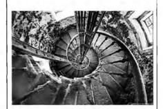
лестницы металлическое с деревянными перилами, литые стойки ограждения; сохранившаяся первоначальная деревянная обшивка стен с деревянными заклепками, металлическая винтовая, затем прямая лестница в верхней части маяка.
