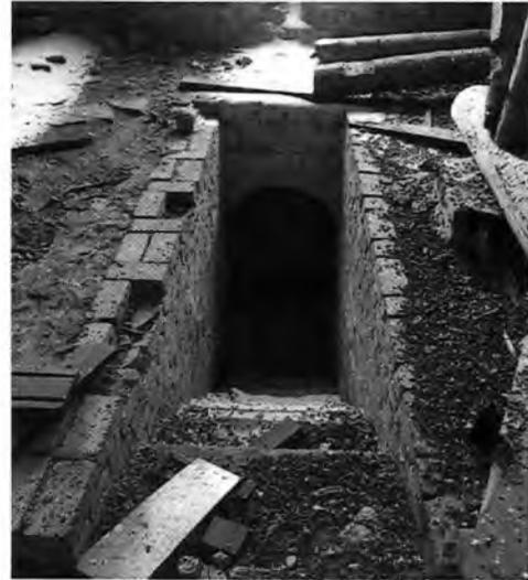
Каменная внутрстенная лестница в подвал, перекрытая кирпичными сводами.
