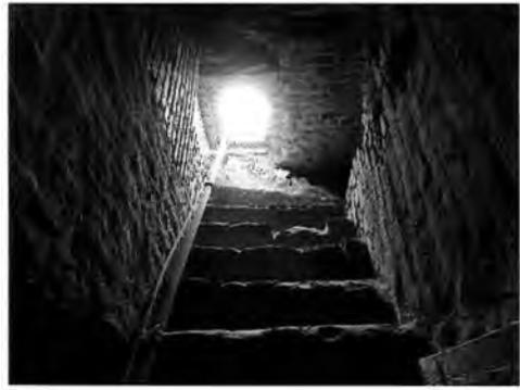
Каменная внутрстенная лестница на чердак, перекрытая в толще наружной стены кирпичными сводами.
