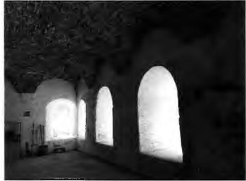
Коробовые кирпичные сводчатые перекрытия трапезной в углах переходящие в сомкнутые, с распалубками к оконным и дверным проемам, усиленные по углам и попарно с центральным столбом стальными связями\*
