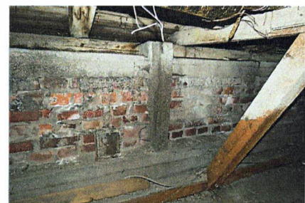
Ж/б ферма венчающего карниза
