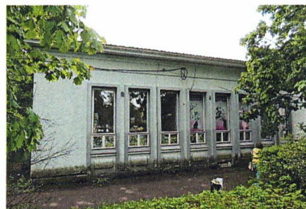
Боковой восточный фасад
