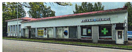
Лицевой северный фасад
