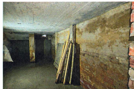
Подвал ((пом. 0.7). Монолитное перекрытие. Опорные столбы
