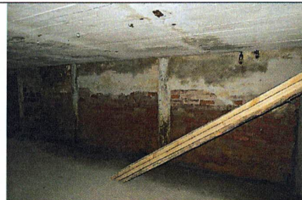
Подвал (пом. 0.5). монолитное перекрытие. Опорные столбы
