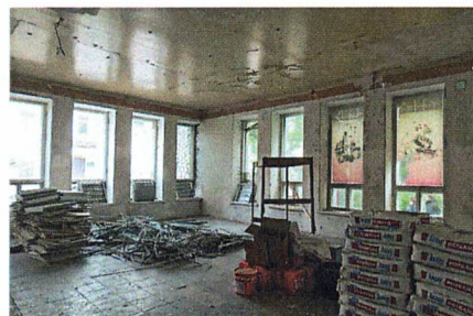
Плоское перекрытие (пом. 1.1)
