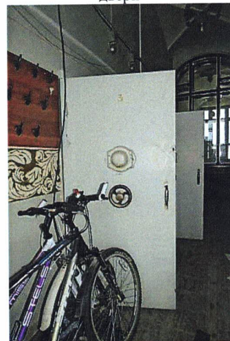
Металлическая дверь сейфа (пом. 1.17). Внешняя сторона
