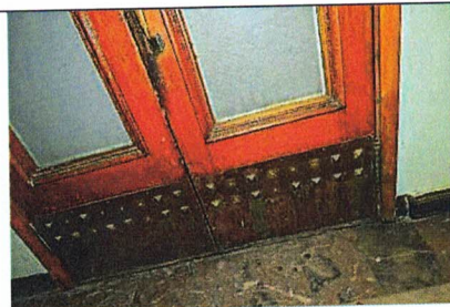
Дверь (между пом. 1.4 и 1.9). Металлическая обвязка
