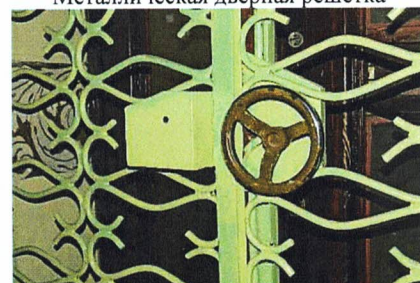
Металлическая дверная решетка (пом. 1.24). Фрагмент
