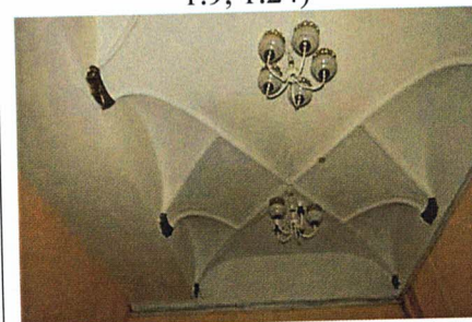
Трехцентрованный свод с распалубками (1-ый этаж, пом. 1.11)
