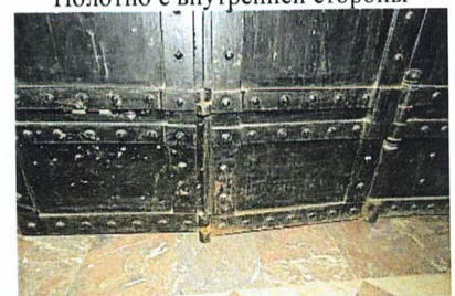
Металлические двери (пом. 1.4). Фрагмент.
