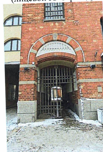
Арочный проезд (С-З фасад)
