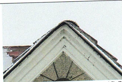
Венчающий карниз щипца (С-3 фасад)
