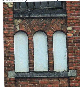
Гранитные подоконные пояса и карнизы (Ю-3 фасад)
