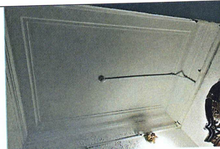
Потолочная галтель (ЛК-2, 2-ой этаж)
