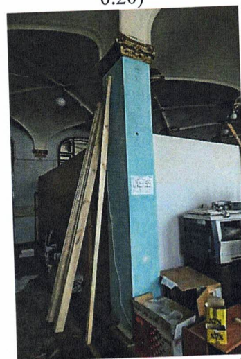
Колонна (1-ый этаж, пом. 1.9)
