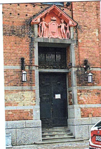
Портал парадного входа (лицевой Ю-З фасад)
