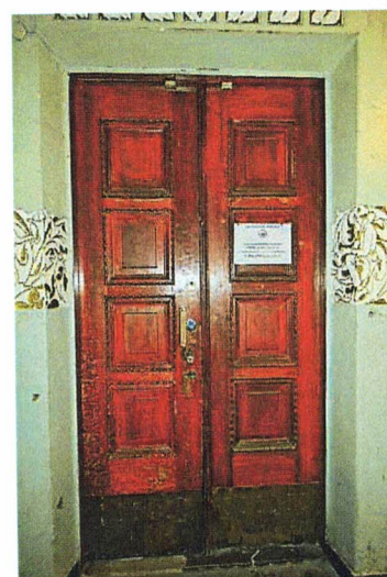
Дверь (пом.1.1). Вход в пом.ЛК-1
