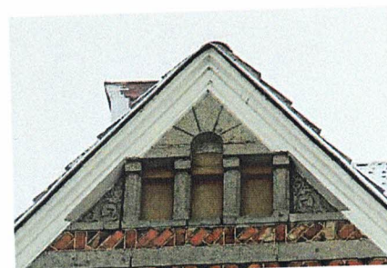
Декор щипцов, С-3 фасад
