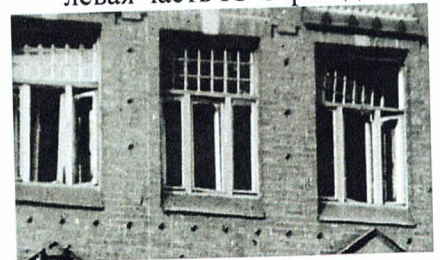
Оконные проемы 2-го этажа, Ю-3 и С-3 фасады (фото 1941 г.)
