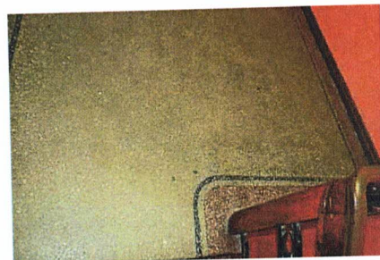
Пол бетонный мозаичный (ЛК-1, 2-ой этаж)
