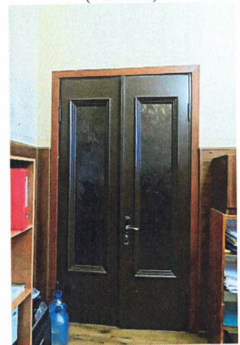
Дверь (между пом. 1.9 и 1.16)
