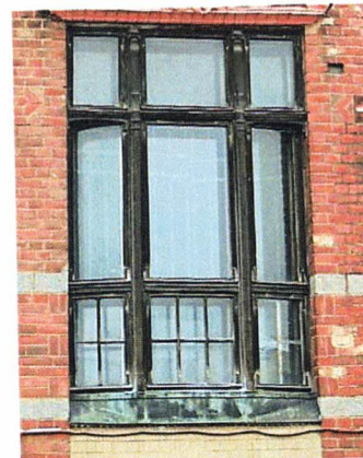
Оконный проем, 1-ый этаж, С-3 фасад
