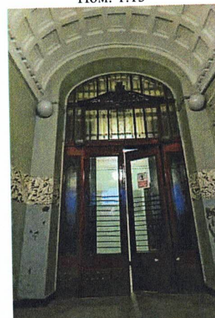
Арочный проем (пом. 1.1- 1.4)
