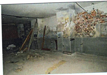
Опорные столбы (подвал, пом. 0.18)
