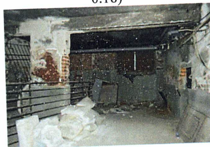
Опорные столбы (подвал, пом. 0.20)
