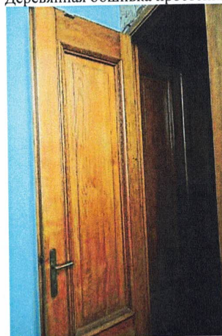
Двери (между пом. 1.10 и 1.13). Деревянная обшивка прстенка
