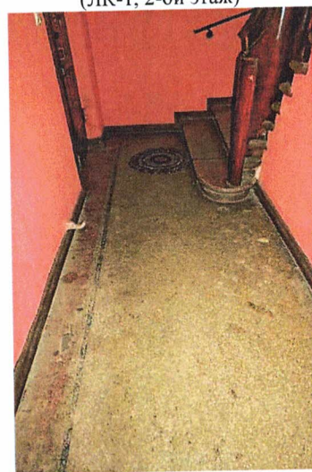
Пол бетонный мозаичный (ЛК-1, 1-ый этаж)
