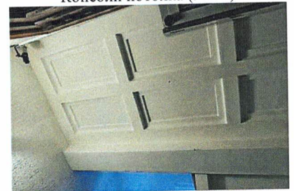
Кессонный потолок (ЛК-2, 1 этаж)
