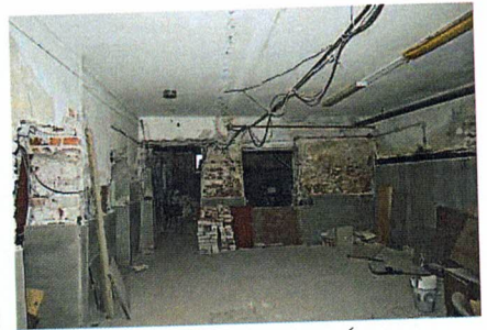
Плоское перекрытие (подвал, пом. 0.17)
