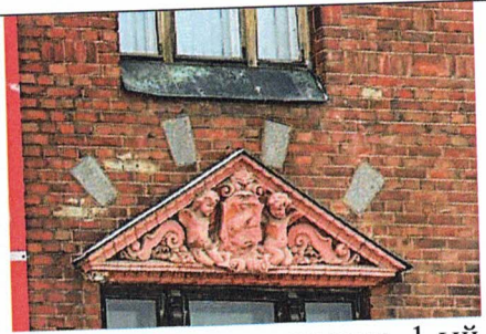
Сандрик оконного проема, 1-ый этаж, С-З фасад
