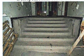
Гранитная лестница (пом. 1.1)
