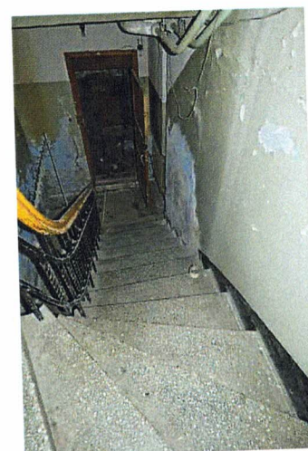
Бетонная лестница Л-5
