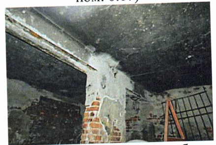
Плоское перекрытие по ребрам (подвал, пом. 0.20)
