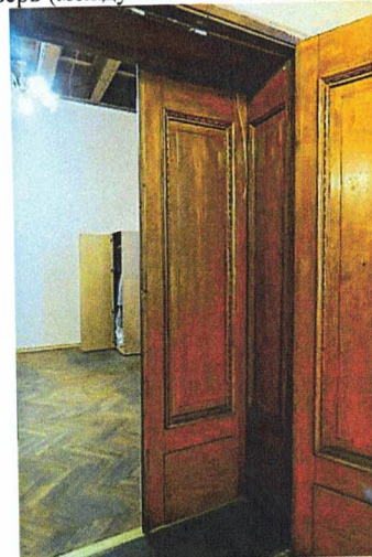
Двери (между пом. 1.7 и 1.13). Деревянная обшивка прстенка
