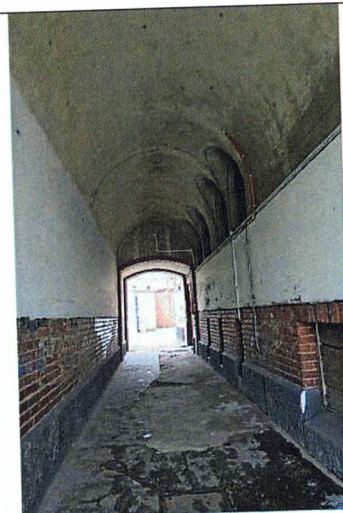
Полуциркульный свод арочного проезда
