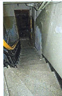
Бетонная лестница Л-5
