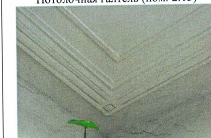
Потолочная галтель (пом. 2.22), утрачена – подлежит восстановлению. Фото 2009 г.
