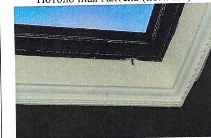
Потолочная галтель (пом. 2.15)
