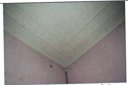
Потолочная галтель (пом. 2.4)
