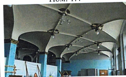
Трехцентрованные своды с распалубками (1-ый этаж, пом. 1.9, 1.24)
