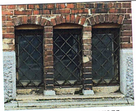
Оконные проемы цоколя (уличные фасады)
