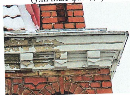
Венчающие карнизы (уличные фасады)
