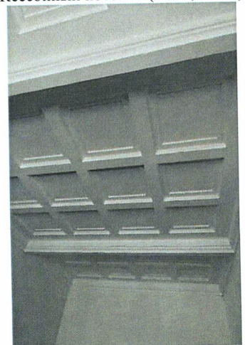
Кессонный потолок (ЛК-2, промежуточный этаж)
