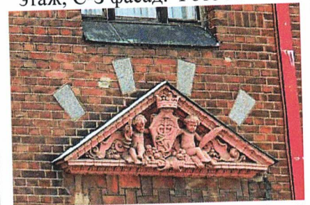
Сандрик оконного проема, 1-ый этаж, С-З фасад
