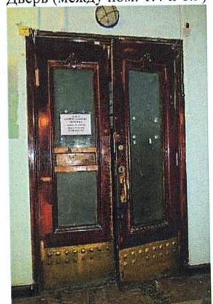
Дверь (между пом. 1.4 и 1.24)
