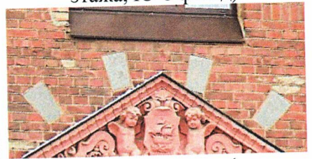
Гранитные вставки (над сандриками боковых проемов 1-го этажа, С-3 фасад)
