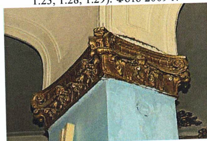
Капитель колонны (пом. 1.9)
