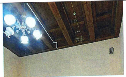
Деревянный потолок (пом. 1.7)
