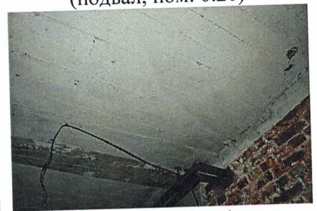
Плоское перекрытие (подвал, пом. 0.25)
