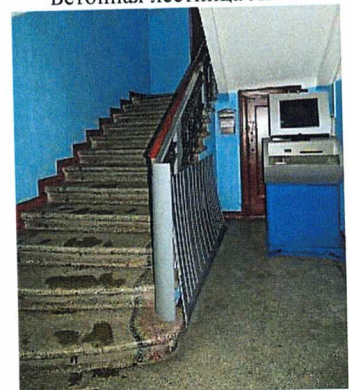
Бетонная лестница ЛК-2
