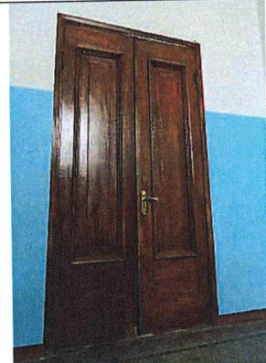
Дверь (между пом. 1.9 и ЛК-2)
