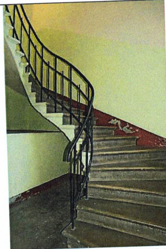
Бетонная лестница ЛК-3
