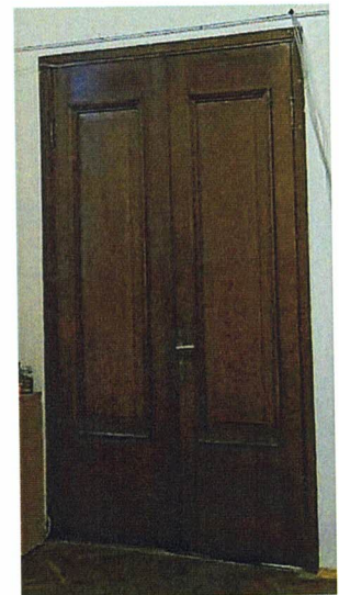
Дверь (между пом. 1.7 и 1.13)
