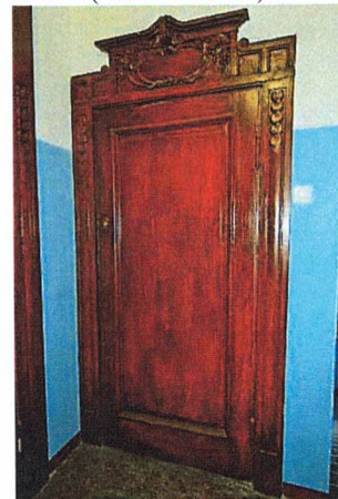
Дверь (между ЛК-2 и пом. 2.26)
