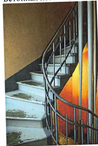
Бетонная лестница ЛК-4
