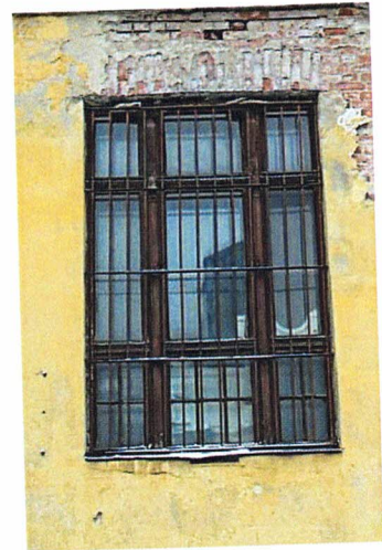
Оконный проем 1-го этажа, Ю-В дворовой фасад
