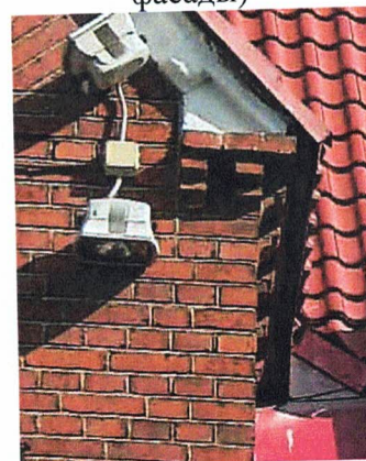
Венчающий карниз надстроенного объема щипца
