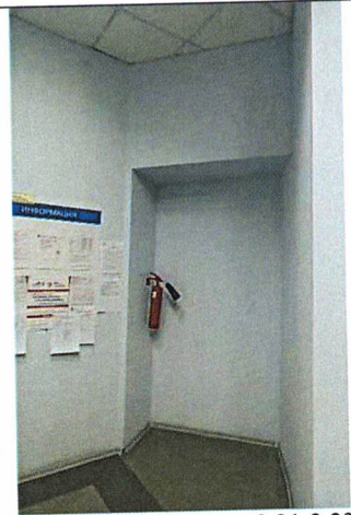
Арочный проем (пом. 2.21-2.23)
