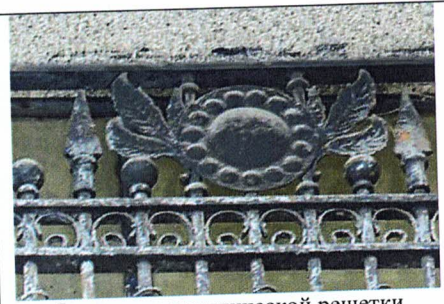
Фрагмент металлической решетки (парадный вход)
