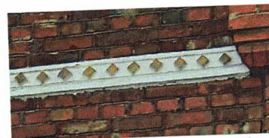
Поясок с кирпичными ромбами (уличные фасады)
