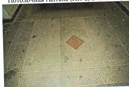
Пол из гранитных плит (пом. 1.1)
