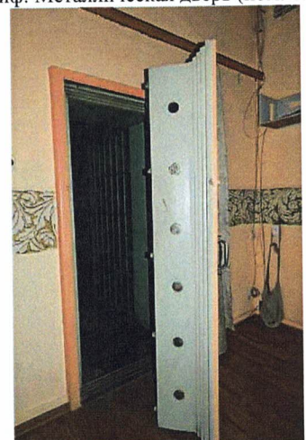
Сейф. Металлическая дверь (пом. 1.12)
