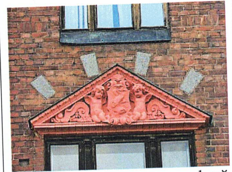
Сандрик оконного проема, 1-ый этаж, С-З фасад. Фото 2009 г.
