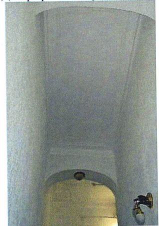
Арочные проемы (ЛК-2)
