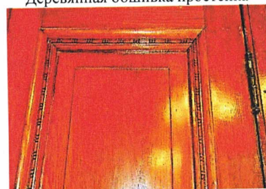
Дверь (пом. 1.13). Фрагмент
