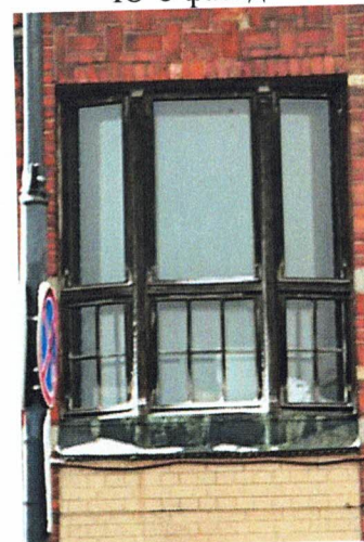
Оконный проем, 1-ый этаж, С-3 фасад
