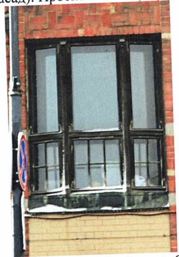
Оконный проем, 2-ой этаж, С-3 фасад
