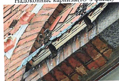
Деталь надоконного карниза (Ю-3 фасад)
