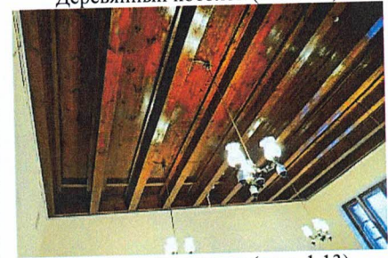
Деревянный потолок (пом. 1.13)
