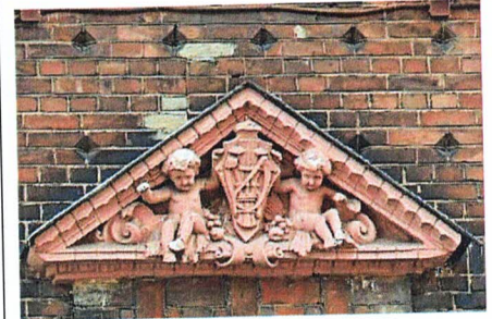
Сандрик оконного проема, 1-ый этаж, Ю-3 фасад
