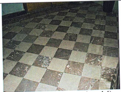
Пол из мраморных плит (пом.1.4)
