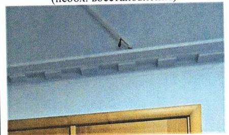
Деревянный карниз (пом. 2.17)
