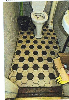
Пол из керамической плитки (пом. 1.8)
