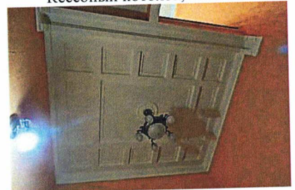
Кессонный потолок (верхняя площадка ЛК-1)
