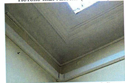
Потолочная галтель (пом. 2.5)
