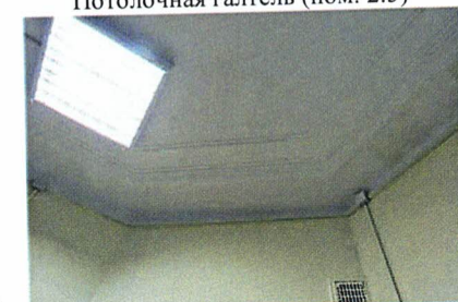
Потолочная галтель (пом. 2.6)
