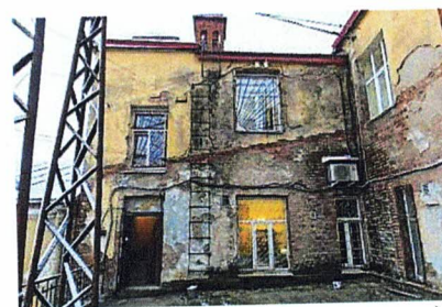
С-В дворовой фасад (верхние ярусы)
