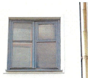
Обрамление проема 2-го этажа. Уличный С-В фасад
