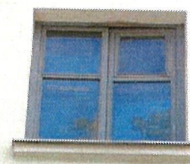
Подоконная тяга оконного проема дворового С-З фасада
