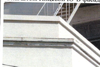
Венчающей карниз одноэтажного пристройки
