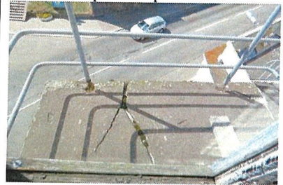
Плита балкона (уличный Ю-3 фасад)
