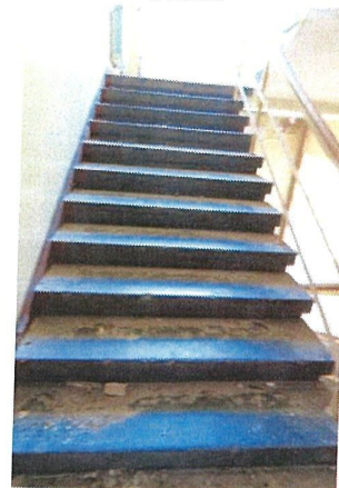
Лестница ЛК-1. Марш с 3-го этажа на 4-ый этаж
