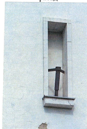
Обрамление проема в уровне чердака. Лицевой Ю-В фасад
