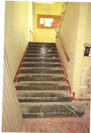
Лестница ЛК-1. Марш 1-го этажа
