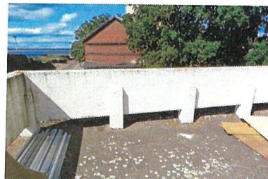
Терраса, ее ограждение (крыша пристройки к основному объему)
