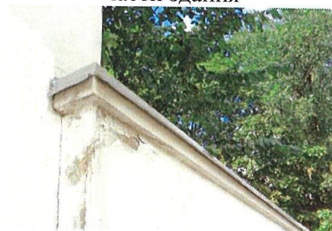
Венчающий карниз ограждающей стены
