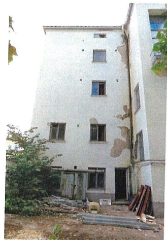
Левая часть дворового С-3 фасада
