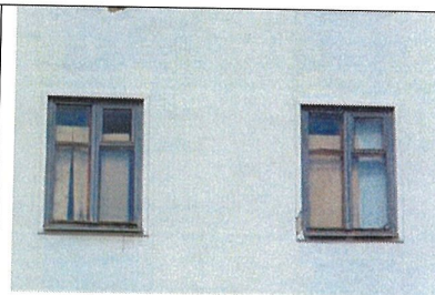
Обрамление проемов 2-го этажа. Лицевой Ю-В фасад
