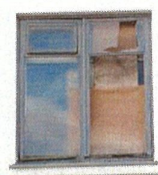
Подоконная тяга уличного С-В фасада
