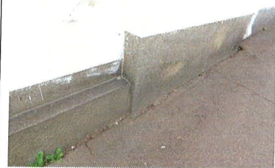
Гранитный цоколь. Уличный С-В фасад
