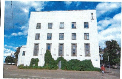
Лицевой Ю-В фасад
