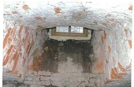
Междуэтажные деревянные по деревянным несущим балкам с деревянным заполнением и металлические и бетонные монолитные (воссозданные), кирпично-горшечные своды с распалубками – над коридорами.
