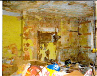
1-ый этаж (помещение в уличном объеме). Плоское ж/б перекрытие. Фото 2006 г.
