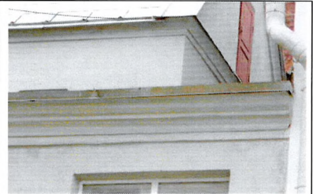
Венчающий карниз дворового крыла
