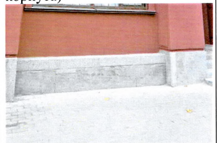
Гранитный цоколь (лицевой Ю-В фасад)
