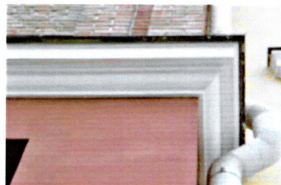
Межэтажный карниз (лицевой Ю-В фасад)
