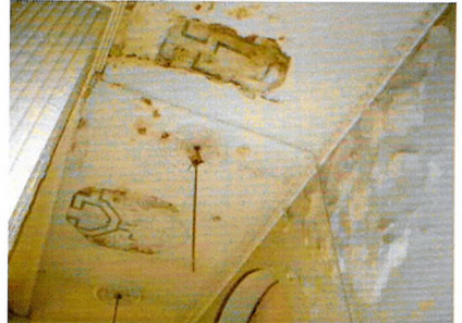
Потолочные росписи и розетки (1-ый этаж, нефы зала). Фото 2006 г.
