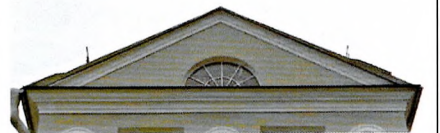
Венчающий карниз (фронтон С-В фасада дворового корпуса)
