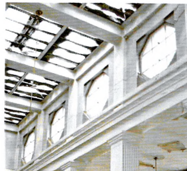
Венчающий карниз; лопатки проемов и балки перекрытия нефов зала и надстройки светового фонаря). Фото 2006 г.
