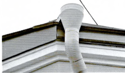
Венчающий карниз дворовых фасадов уличного объема
