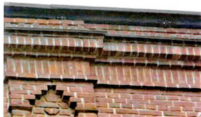
Венчающий карниз с парапетом (лицевой Ю-В фасад)
