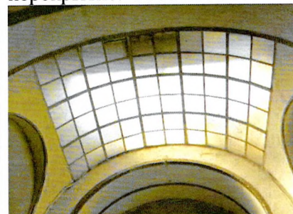
1-ый этаж (холл). Сводчатое перекрытие светового фонаря. Фото 2006 г.
