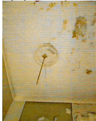
1-ый этаж (операционный зал). Плоское ж/б перекрытие. Фото 2006 г.
