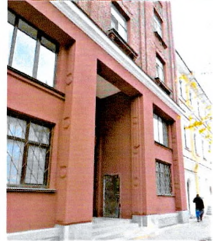
Декоративное оформление портала и откосов проемов (лицевой Ю-В фасад, 1-ый и 2-ой этажи)
