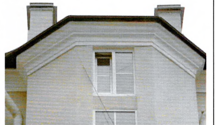
Венчающий карниз (дворовый корпус)
