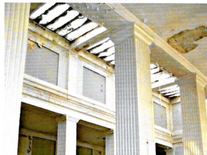
Венчающие карнизы; лопатки проемов и балки перекрытия нефов зала и надстройки светового фонаря). Фото 2006 г.
