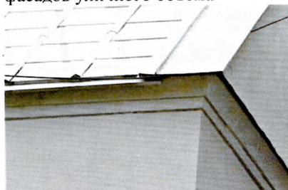
Венчающий карниз надстройки над операционным залом
