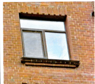
Оформление оконного проема 6-го этажа (лицевой Ю-В фасад)
