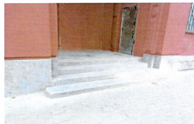
Входные ступени главного входа (лицевой Ю-В фасад)
