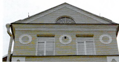
Розетки (простенки фасадов дворового корпуса)
