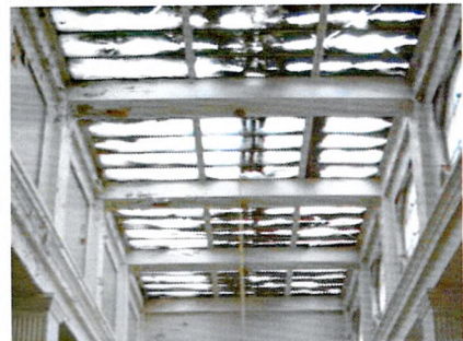
1-ый этаж (операционный зал). Плоское балочное перекрытие надстройки светового фонаря над операционным залом. Фото 2008 г.
