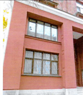
Оформление оконных проемов (лицевой Ю-В фасад)
