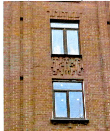
Оформление оконных проемов 4-го и 5-го этажей (лицевой Ю-В фасад)
