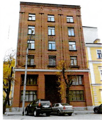
Лицевой Ю-В фасад
