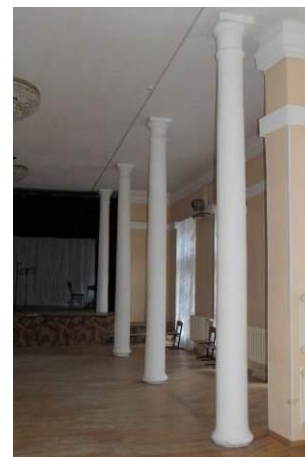
Колонны зала (1-ый этаж)
