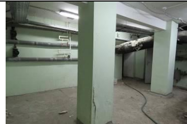
Плоское ж/б перекрытие и опорные столбы (подвал)
