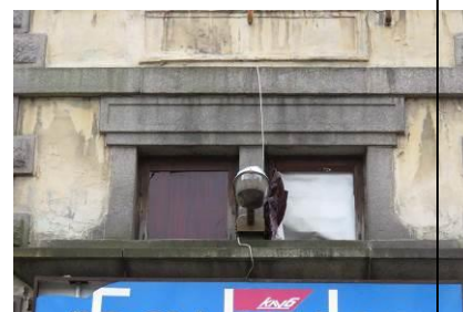
Обрамление проема над входом (Ю-В фасад)
