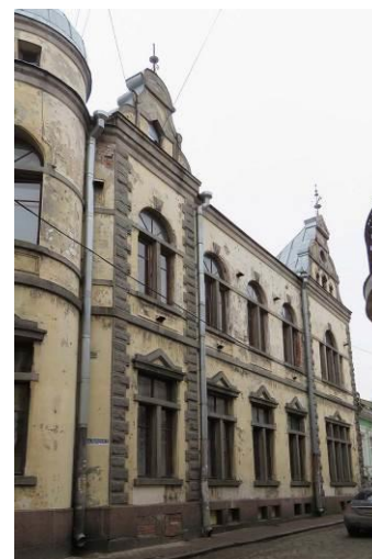
Уличный северо-восточный фасад
