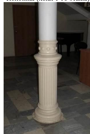
База колонны (холл 1-го этажа)
