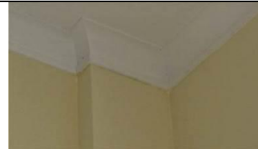
Паддуга (помещение в средней С-В части здания, 2-ой этаж)
