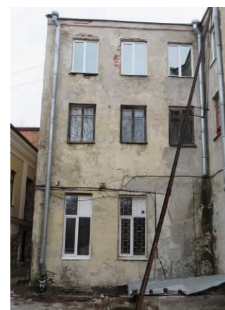
Дворовый юго-восточный фасад западного крыла
