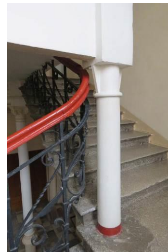
Опорный столб площадки 2-го этажа
