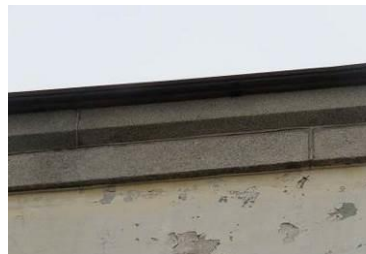
Венчающий карниз основной плоскости уличных фасадов
