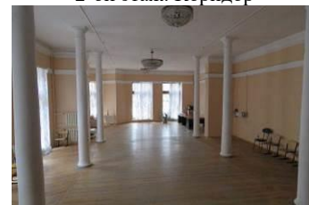
1-ый этаж. Парадный зал. Плоское перекрытие, колонны
