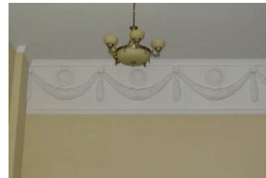
Настенный фриз (помещение в средней С-В части здания, 2-ой этаж)
