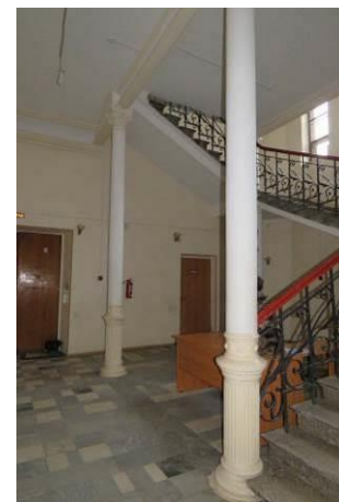
1-ый этаж. Помещение парадной лестницы. Колонны.
