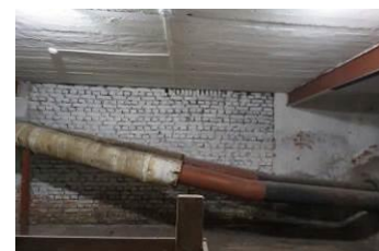
Плоское ж/б перекрытие (подвал)
