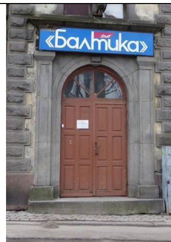
Обрамление портала главного входа (Ю-В фасад)
