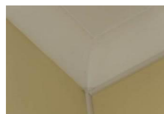
Паддуга (помещение 2-го этажа в северной части здания)
