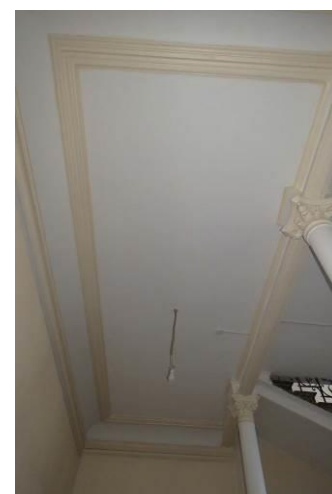
Потолочный фриз (холл 1-го этажа)
