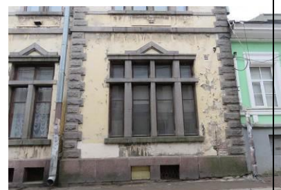
Обрамление оконного проема 1-го этажа (правый ризалит С-В фасада)
