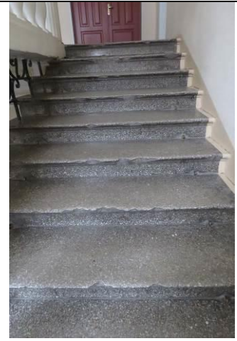
Марш парадной лестницы на 2-ой этаж
