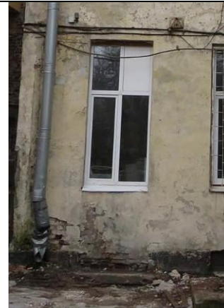
Вход (дворовый Ю-В фасад)
