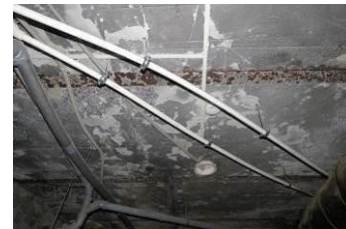
Плоское ж/б перекрытие (подвал)
