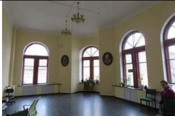
2-ой этаж. Угловое помещение. Плоское перекрытие
