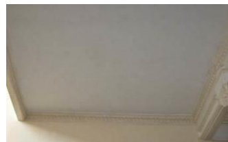
Потолочный карниз (1-ый этаж)
