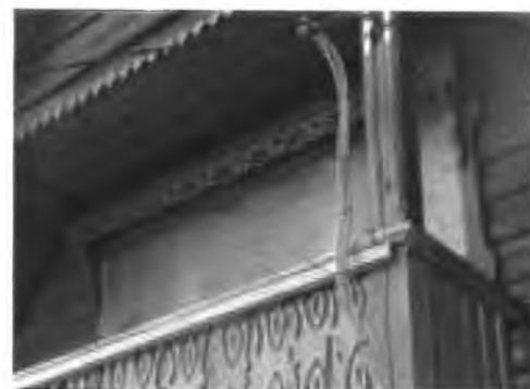
двускатный навес балкона, выступающий за плоскость кровли, поддерживается двумя столбами прямоугольного сечения;
