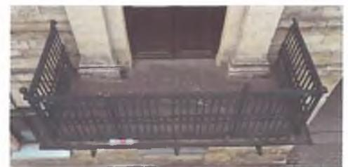
Балконная плита чугунная защемлена в кладку стены: местоположение, габариты, материал (чугун).
