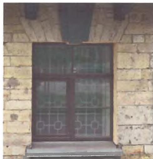
Оконные проемы 1 этажа: местоположение, габариты, конфигурация (прямоугольные с клинчатыми перемычками и плоскими замковыми камнями), отметка перемычки.
