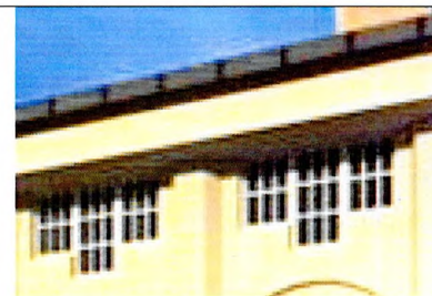
Оконные проемы 3-го этажа уличных фасадов (реконструкция на 1939 г.).
