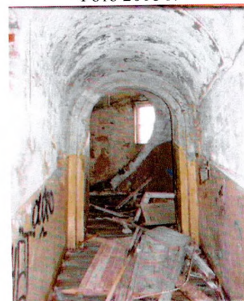
Свод парадного входа и парадная лестница. 1-ый этаж, Ю-В крыло. Фото 2009 г.
