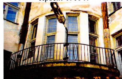
Балкон. Дворовый ризалит. Фото 2003 г. (копия)
