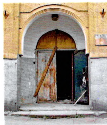
Парадный вход. Ю-В фасад
