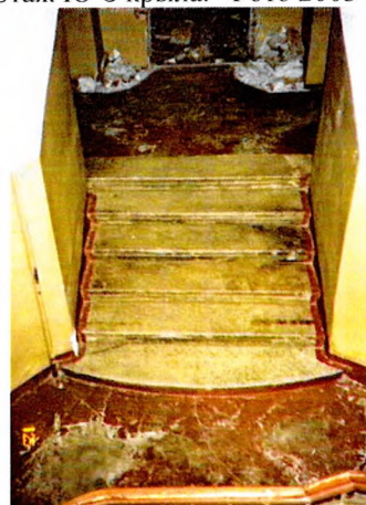
Лестница в помещения 2-го этажа Ю-З крыла с центральной ЛК. Фото 2003 г.
