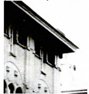
Нижний выносной карниз. Уличные фасады. Фото 1910-х гг. (копия)
