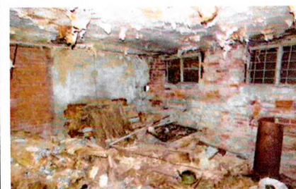
Подвал, помещение в Ю-В крыле. Фото 2016 г.
