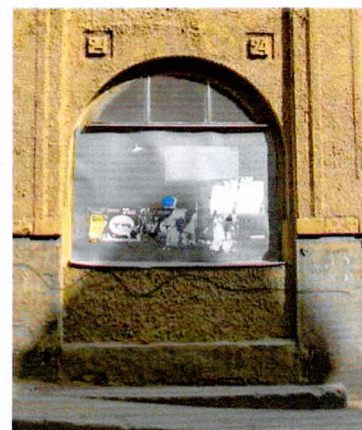
Парадный вход. Ю-З фасад
