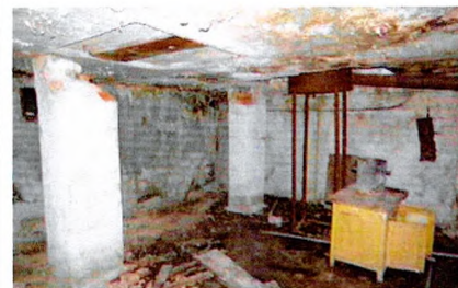
Подвал. Помещение под внутренним двором. Фото 2016 г.
