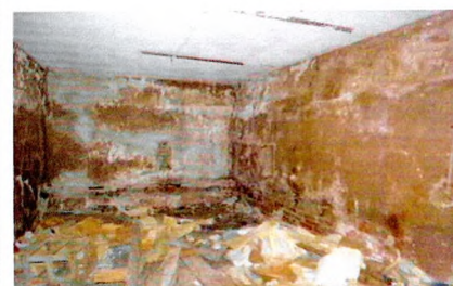
Подвал, помещение в Ю-З крыле. Фото 2016 г.
