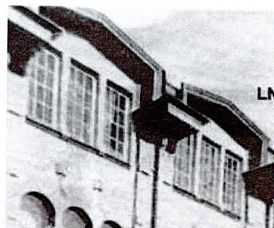
Проемы в левой части 3-го этажа уличного Ю-З фасада здания. Фото 1920-х гг. (копия)
