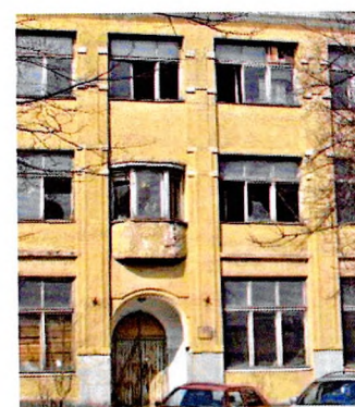
Лопатки. Лицевой Ю-В фасад. Фото 2009 г.
