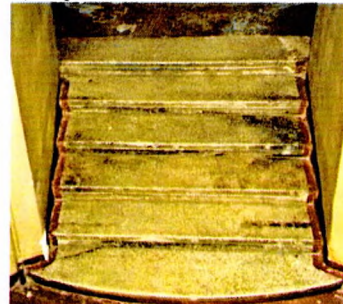
Лестница. Вход в помещения 2-го этажа Ю-3 с центральной ЛК. Фото 2003 г.
