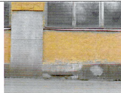
Сохранившаяся гранитная ступень входа. Правая сторона Ю-В фасада
