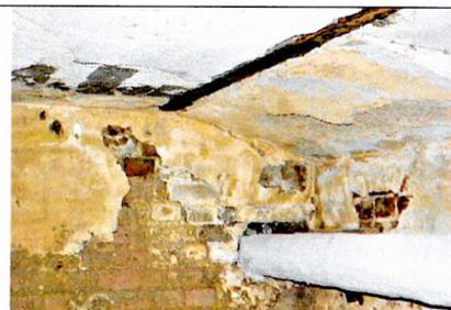
Подвал. Перекрытие монолитное ж/б в восточной части уличного объема
