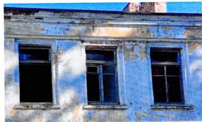
исторические местоположение, габариты, профили утраченного декора выпущенного кирпича – прямоугольные ниши над сдвоенными оконными проемами 1-го этажа.
