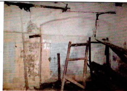
Проем с цилиндрической перемычкой и лестница, ведущая из пом.31 в главный вестибюль – габариты, местоположение, профиль проступи (с валиком), материал – наливные ступени в технике терраццо;
