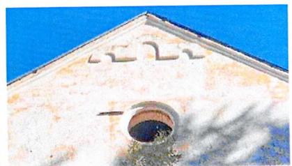
Исторические местоположение и габариты трех небольших оконных проемов с полуциркульным завершением, находящихся в венчающей части щипца под аркатурным поясом\*;
