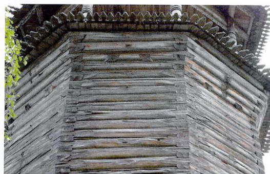
Габариты, конструкция, техника исполнения и материал звонницы и завершения колокольни – деревянный восьмигранный шатер с вертикально ориентированным тесовым покрытием, где верхний слой – дороженный, с тесовой полицей, где верхний слой – дороженный красный тес, и завершением из цилиндрического барабана и главки с крестом, поддерживаемый 8 резными столбами по углам восьмерика и устроенным дощатым ограждением между ними.
