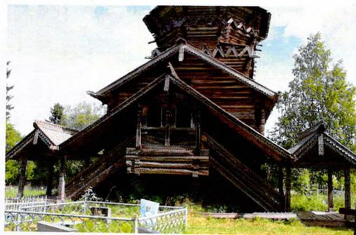
концом на остатки сруба угла четверика, покрытие углов – тесовое по историческим следам на срубе с устройством отвода осадков в угловой поток.
