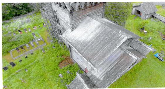
Местоположение, конфигурация, конструкция, габариты, материал и техника исполнения крыльца – двухвходное с устроенным верхним рундуком на консольных бревнах, перекрытых двускатной тесовой крышей, где верхний слой теса – дороженный. У входов устроены нижние площадки, перекрытые отдельными двускатными крышами, поддерживаемыми резными столбами по четырем углам.
