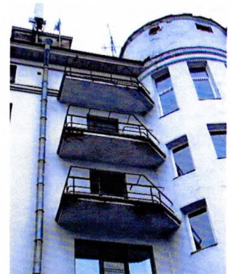
Балконы. Дворовый фасад уличного корпуса
