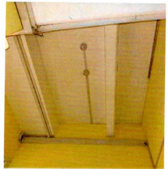
Дворовый корпус. 1-ый этаж. Монолитное ж/б ребристое перекрытие
