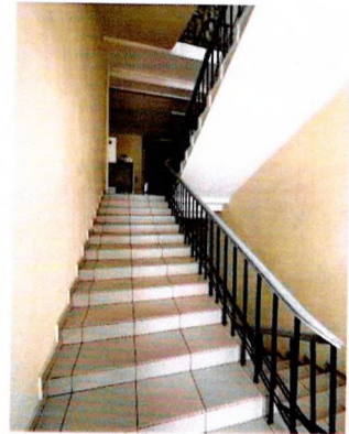
Дворовый корпус. Центральная лестничная клетка
