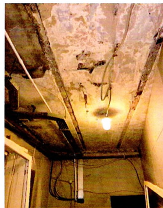
Дворовый корпус. Пом. 0.10. Плоское ж/б перекрытие.
