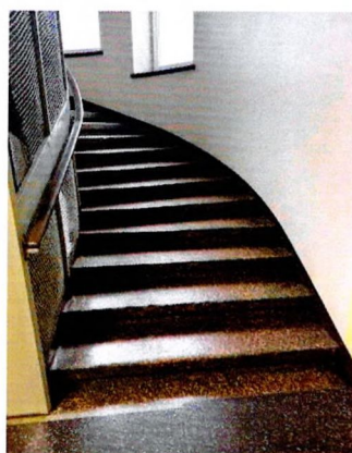
Уличный корпус. Марш центральной лестницы
