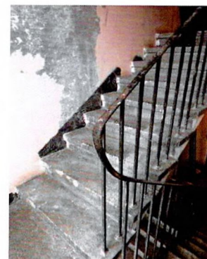
Ограждение лестницы в С-В части уличного корпуса
