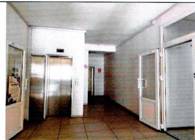
Дворовый корпус. 3-ий этаж. Монолитное ж/б перекрытие
