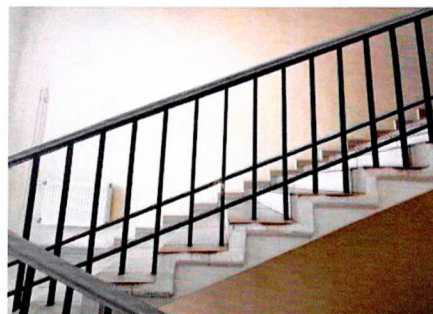
Ограждение центральной лестницы дворового корпуса
