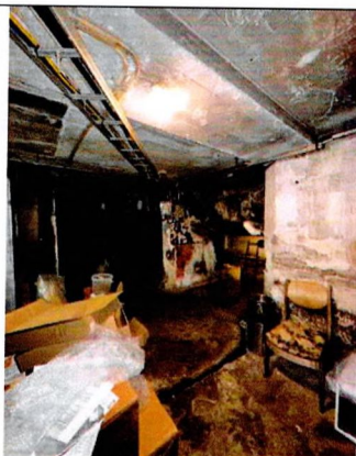
Уличный корпус. Подвал. Пом. 0.21. Монолитное перекрытие
