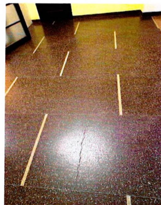
Уличный корпус. Центральная лестничная клетка. Бетонное мозаичное декоративное покрытие холла 2-го и 3-го этажей
