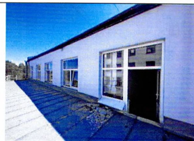
С-3 фасад дворового корпуса. Фрагмент. 4-ый этаж с левой стороны фасада
