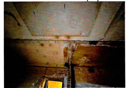
Уличный корпус. Пом. 7.32. Плоское перекрытие
