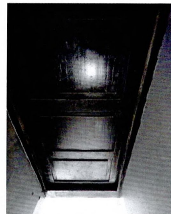
Оформление перекрытия сквозного арочного проезда уличного корпуса
