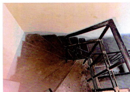
Ограждение лестницы в Ю-3 крыле дворового корпуса
