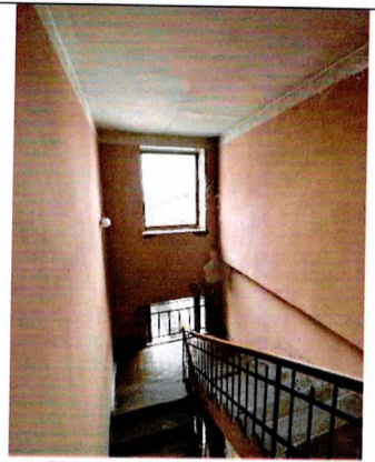
Уличный корпус. ЛК-2. Плоское монолитное перекрытие
