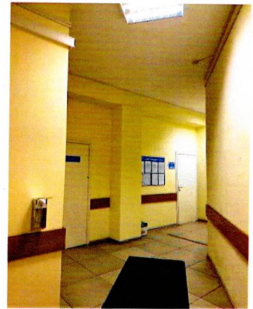
Дворовой корпус. 1-ый этаж. Опорные колонны
