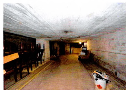
Дворовый корпус. Пом. 0.29. Плоское ж/б перекрытие.
