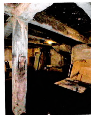
Уличный корпус. Подвал. Пом.0.51. Опорный ж/б столб
