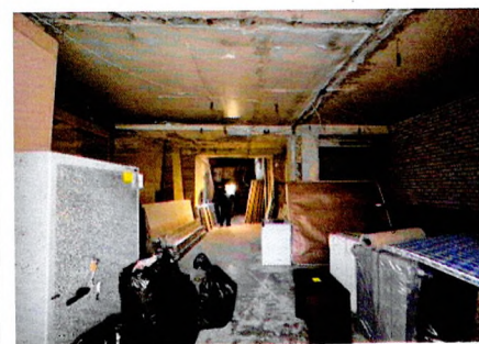
Уличный корпус. Пом. 1.1. Монолитное ж/б перекрытие
