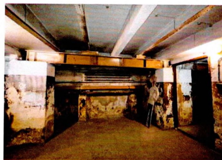
Уличный корпус. Подвал. Пом. 0.44. Монолитное ж/б ребристое перекрытие
