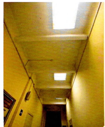
Дворовый корпус. 2-ой этаж. Монолитное ж/б ребристое перекрытие
