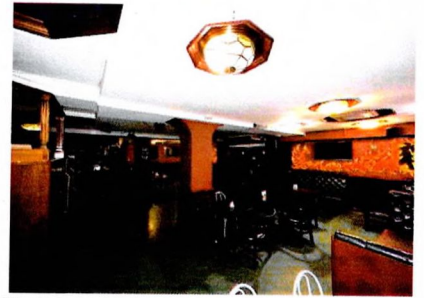
Помещение 1-го этажа в дворовой части уличного корпуса. Опорные колонны
