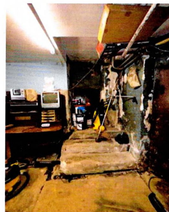
Уличный корпус. Подвал. Пом. 0.6. Бетонная лестница
