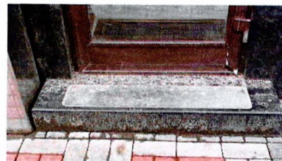
Лицевой фасад уличного корпуса. Входная ступень
