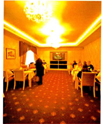
Уличный корпус. Пом. 2.7. Плоское перекрытие
