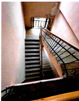
Уличный корпус. Лестница в Ю-З части
