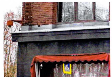
Лицевой фасад уличного корпуса. Карниз между 1-2 этажами
