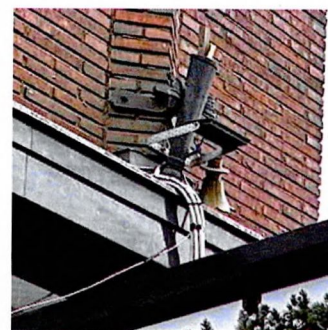
Металлический флагшток. Простенки
