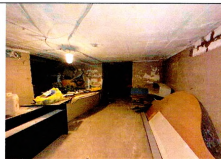
Дворовый корпус. Пом. 0.4. Плоское монолитное ж/б перекрытие.
