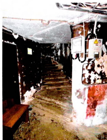
Уличный корпус. Подвал. Пом. 0.21. Бетонный лестничный марш центральной лестницы
