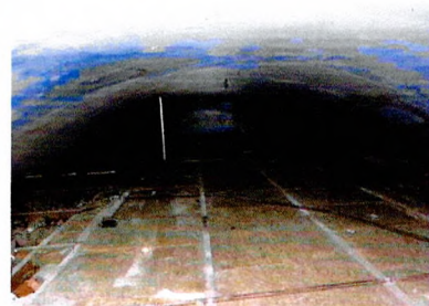
Чердак уличного корпуса. Монолитный ж/б купол
