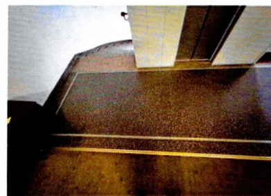
Уличный корпус. Центральная лестничная клетка. Бетонное мозаичное декоративное покрытие холла 4-го и 6-го этажей
