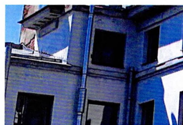
Тяга между 6-ым и 7-ым этажами Ю-В дворового фасада уличного корпуса. и венчающий карниз С-В фасада дворового крыла уличного корпуса
