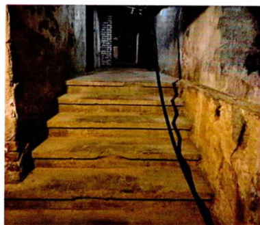
Уличный корпус. Подвал. Пом. 0.45. Бетонная лестница
