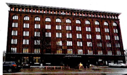
Лицевой С-3 фасад уличного корпуса
