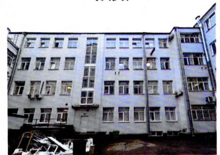
С-З фасад дворового корпуса
