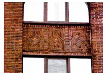
Лицевой фасад уличного корпу-са. Оформление простенков между 2-3 и 5-6 этажами
