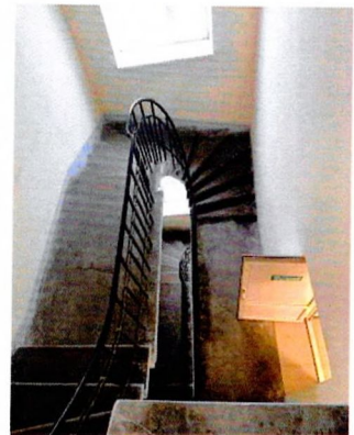
Лестничная клетка в Ю-З крыле дворового корпуса
