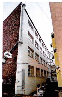
Ю-В фасад дворового корпуса и Ю-3 фасад центрального ризалита. Левая часть
