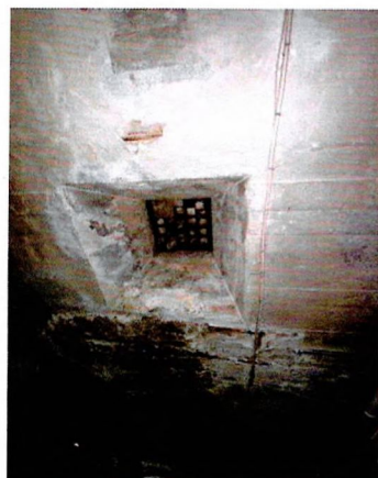
Уличный корпус. Подвал. Монолитное ж/б перекрытие со световым фонарем
