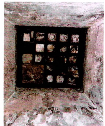
Подвал. Перекрытие двора. Пом. 0.45. Конструкция светового фонаря в перекрытии
