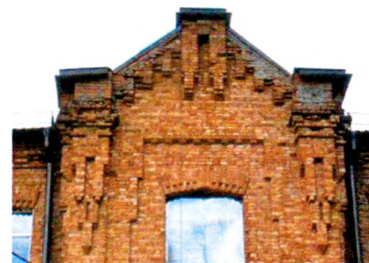
Щипец (ризалит, восточный фасад)
