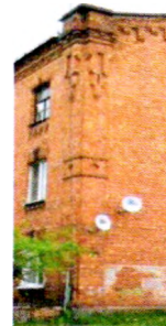
Лопатки, углы фасадов
