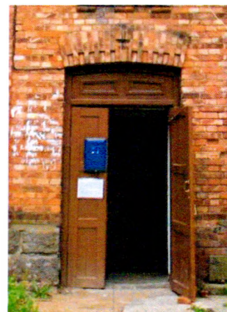
Оформление дверного проема
