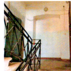
Арочный проем. ЛК-3. 1-ый этаж
