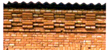
Венчающий карниз (восточный и западный фасады)
