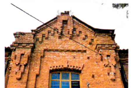
Щипец (ризалит, восточный фасад)
