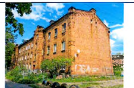
Общий вид здания с Ю-З
