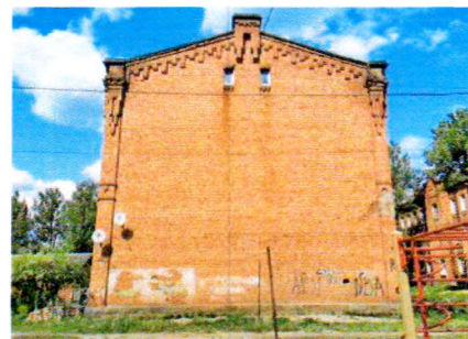
Южный торцевой фасад
