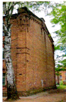
Северный торцевой фасад
