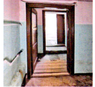
Дверной проем. ЛК-1
