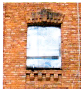
Оформление оконного проема между 2-ым и 3-им этажами (ризалиты, западный фасад)
