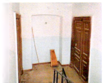
Арочный проем. ЛК-3. 3-ий этаж
