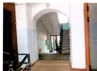
Арочный первоначальный лучковый проем. ЛК-4. 1-ый этаж
