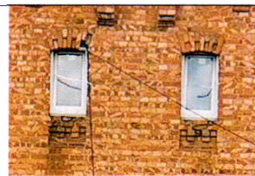
Оформление проемов (торцевые фасады)
