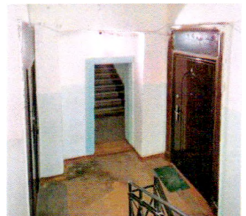
Арочный проем. ЛК-3. 2-ой этаж
