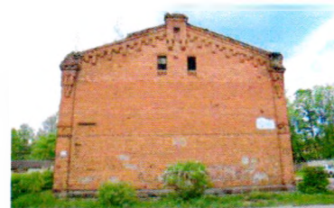
Южный торцевой фасад
