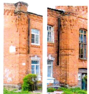
Лопатки, углы фасадов и ризалиты
