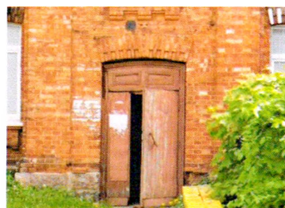
Оформление дверного проема
