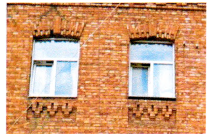
Оформление оконных проемов. 3-ий этаж (квартиры)
