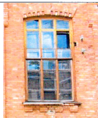
Оформление проема (ризалит. восточный фасад)
