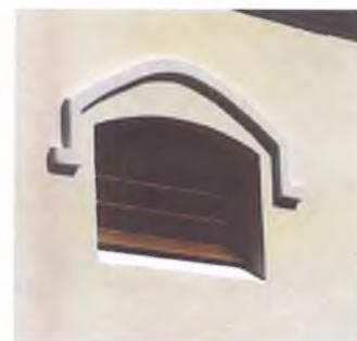
Оконные проемы в шатровой крыше колокольни - местоположение, габариты, конфигурация (с арочной полуциркульной перемычкой), оформление каждого оконного проема подоконной плитой на фигурных консолях, треугольным профилированным сандриком, опирающимся на стилизованные колонки с кубическими вставками в центре, капителями и базами.
