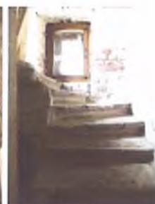
молельный зал с подвалом - в западной части храма - криволинейная в плане, одномаршевая, междустенная, с железобетонными монолитными ступенями, пол площадки - наливной бетонный (местоположение, конфигурации, габариты, материал);
