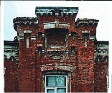
Венчающий карниз двухуровневый с напуском. Верхний пояс гладкий профилированный со ступенчатыми сухариками, нижний – гладкий с Т-образными ступенчатыми сухариками (пирамидками).
