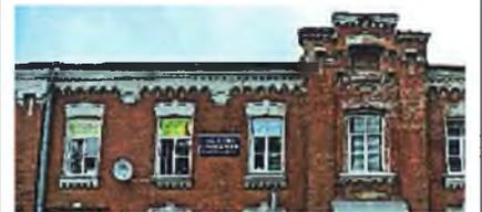
Декоративное оформление оконных проемов с лучковой перемычкой выступающим из плоскости стены замковым камнем с наплывом, который завершается выше перемычки и выше дугового выступающего пояса по верхней кромке перемычки.
