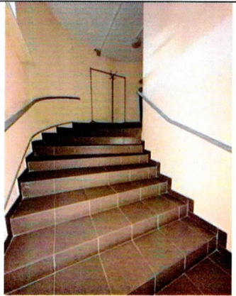
Ж/б лестница. Ю-З угол южного крыла
