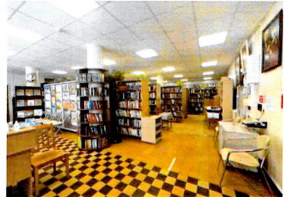
1-ый этаж. Помещение в западной части южного крыла. Монолитное ж/б перекрытие, опорные столбы, кирпичные стены
