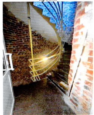
Ж/б лестница. Южная часть восточного крыла
