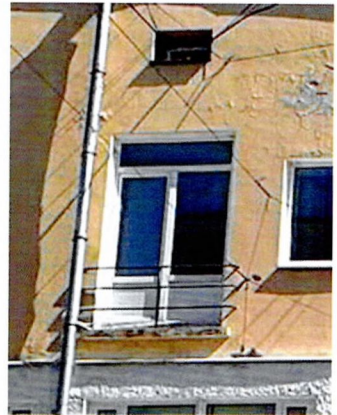
Западный уличный фасад. Ограждение балкона
