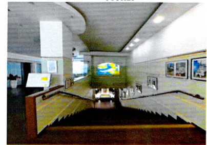
1-ый этаж. Подъем на 2-ой этаж кинотеатра. Плоское монолитное ж/б перекрытие и опорные столбы, кирпичные стены, ж/б лестница
