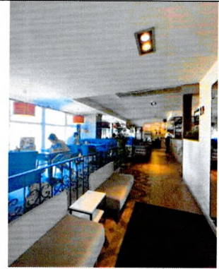
1-ый этаж. Помещение в северной части восточного крыла. Плоское монолитное ж/б перекрытие и опорные столбы, кирпичные стены
