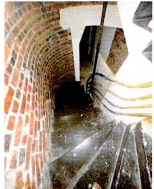
Ж/б лестница. Южная часть восточного крыла
