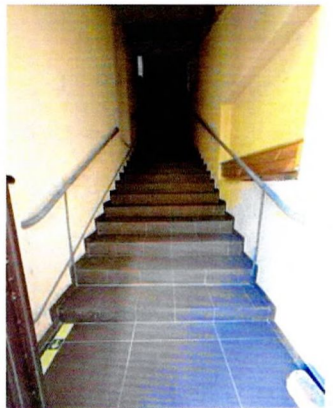
Ж/б лестница. Ю-В угол южного крыла
