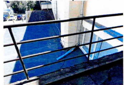
Южный дворовый фасад. Ограждение балкона
