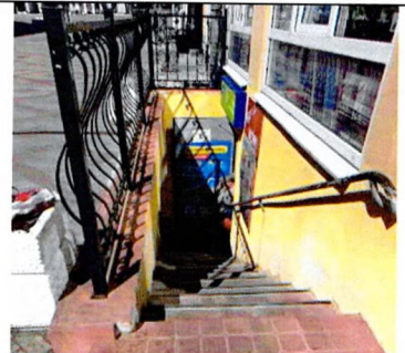
Спуск в подвал (2 шт.). Западный фасад
