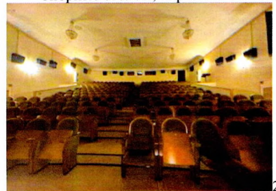
2-ой – 3-ий этажи. Зрительный зал. Плоское монолитное ж/б перекрытие, кирпичные стены
