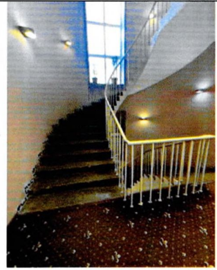
Ж/б лестница гостиницы. Ю-В часть здания
