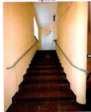
Ж/б лестница. Ю-З угол южного крыла
