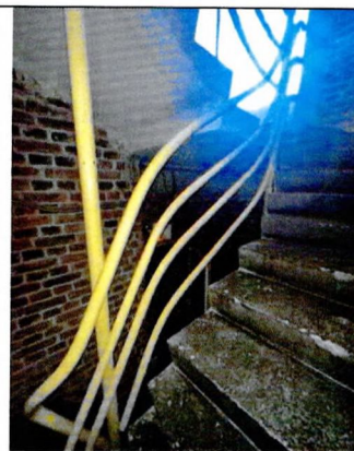
Лестница с Ю-В части северного крыла. Ограждение
