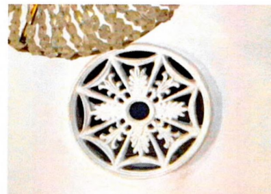
Потолочная розетка. Зрительный зал. Южное крыло
