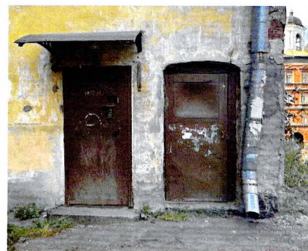
Дверные проемы. Ю-В фасад дворового крыла
