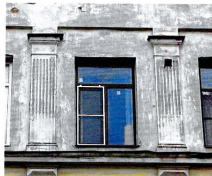
Простенки оконных проемов 3-го яруса. Лицевой Ю-3 фасад
