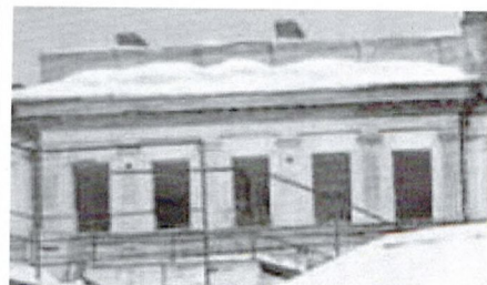
Простенки оконных проемов 3-го яруса. Лицевой Ю-3 фасад. Фото (копия) 1942 г.
