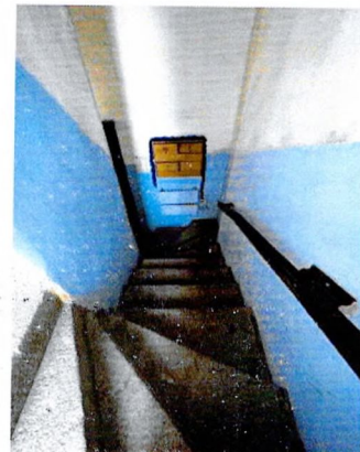
Лестница. Дворовое крыло
