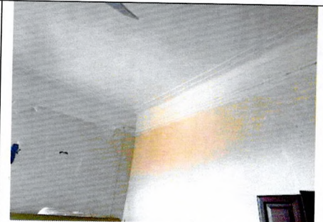
Плоское перекрытие (квартира, 3-ий этаж)
