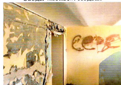
Своды «монье», подвал
