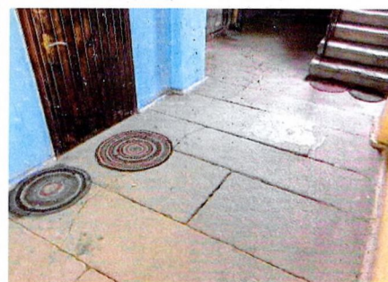
Полы гранитные. Парадный вход, верхняя площадка
