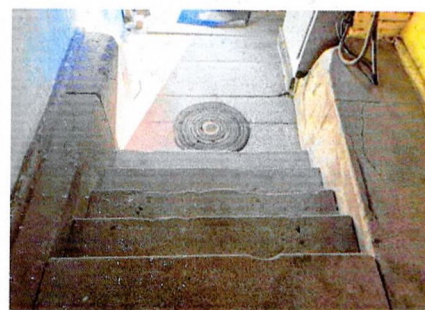
Полы гранитные. Парадный вход, нижняя площадка
