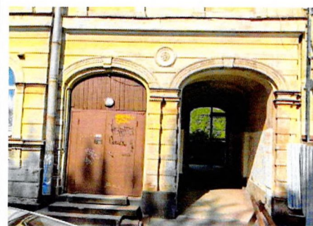
Арочные проемы парадного входа и сквозного проезда
