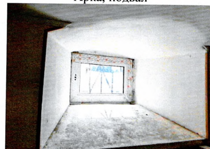
Распалубка арочного оконного проема, подвал
