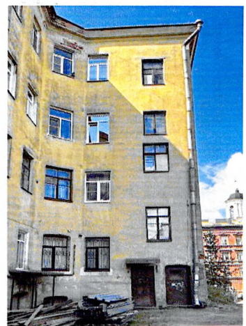
Ю-В фасад дворового крыла
