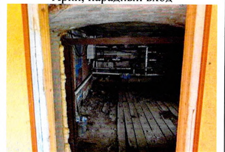
Арочный проем, подвал
