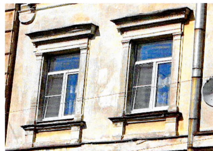
Проемы 2-го яруса боковых частей. Лицевой Ю-3 фасад
