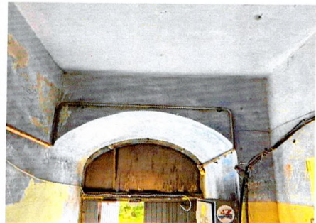
Существующее плоское перекрытие входной зоны
