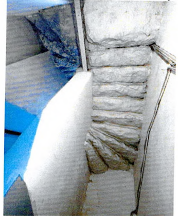
Гранитные ступени промежуточного марша лестницы дворового крыла
