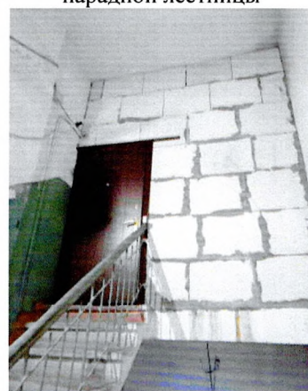
Существующее плоское перекрытие лестничной клетки дворового крыла
