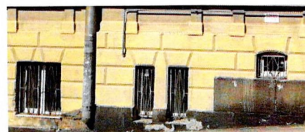
Проемы цокольного яруса и подвала. Лицевой Ю-З фасад
