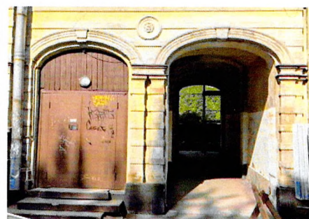
Проемы парадного входа и сквозного проезда. Лицевой Ю-З фасад
