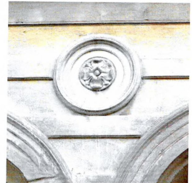
Розетка. Лицевой Ю-З фасад, верхняя часть простенка между архивольтами проемов входа и сквозного проезда
