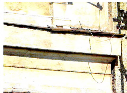
Карниз между 1-ым и 2-ым ярусами. Лицевой Ю-3 фасад
