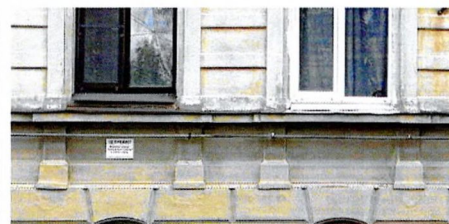
Фриз, совмещенный с карнизом между нижним ярусом и 1-ым ярусом. Лицевой Ю-3 фасад
