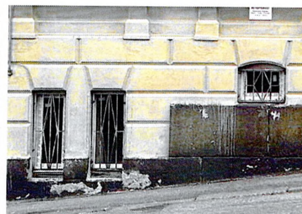
Проемы цокольного и подвального ярусов. Лицевой Ю-З фасад
