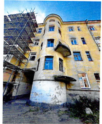
Фрагмент дворового С-В фасада. Левая часть
