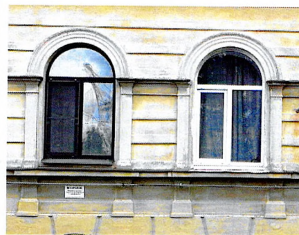
Проемы 1-го яруса. Лицевой Ю-3 фасад
