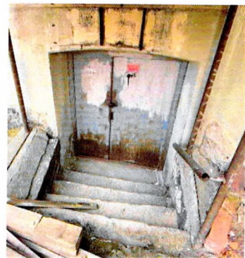
Вход в подвал. С-В дворовый фасад
