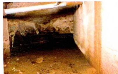
Нижний ярус. Кирпичный полусвод, стены из гранитных валунов и монолитные ж/б
