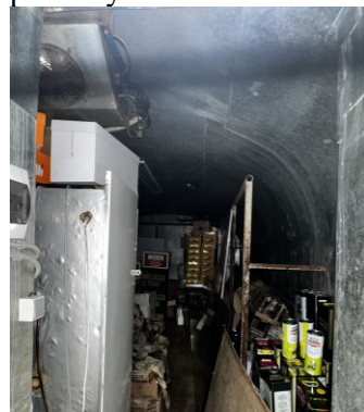
1-ый этаж. Ю-З часть С-З объема. Сводчатое перекрытие
