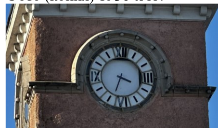
Проем часов. Ю-В фасад башни
