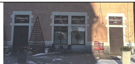
Оформление оконных и дверных проемов. Левый ризалит. Ю-З фасад
