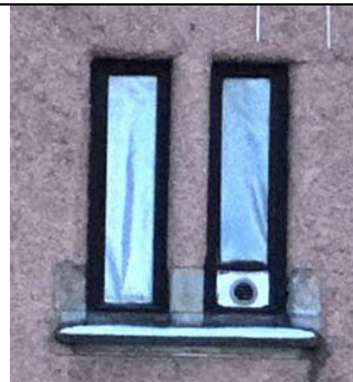
Оконные проемы среднего ризалита. С-В фасад
