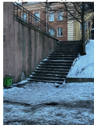
С-З фасад. Лестница на верхний уровень
