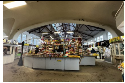
1-ый этаж. Ю-В часть. Свод входной зоны в зал
