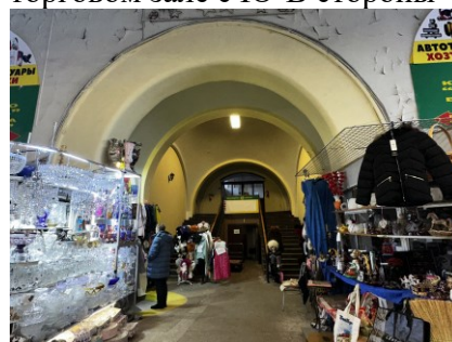
Обрамление арочного проема входа в торговый зал с С-З стороны
