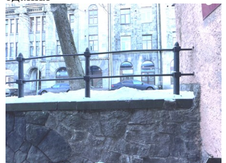
Фрагмент подпорной стены с Ю-З стороны здания
