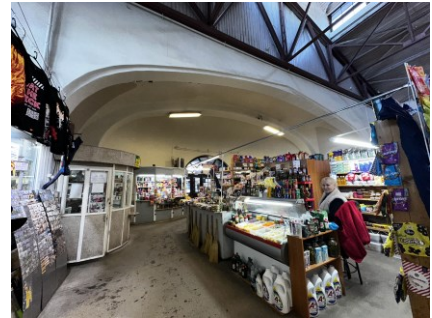
1-ый этаж. Ю-В часть. Свод и арчный проем входной зоны
