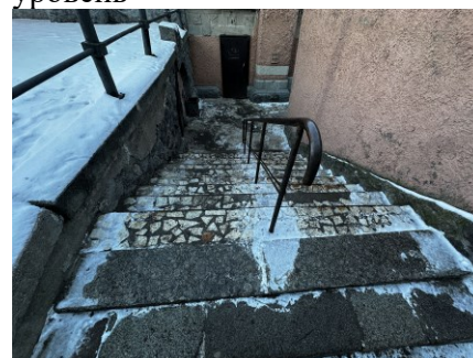
Ю-З фасад. Лестница на верхний уровень
