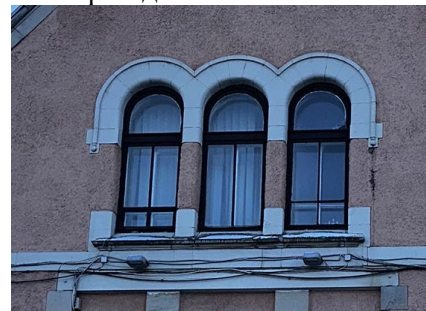
Оконные проемы левого ризалита. С-В фасад
