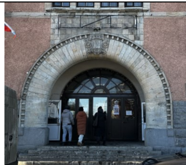
Обрамление проема портала главного входа. Ю-В фасад
