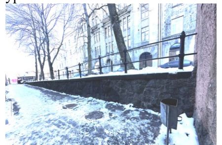
Подпорная стена с Ю-З стороны здания
