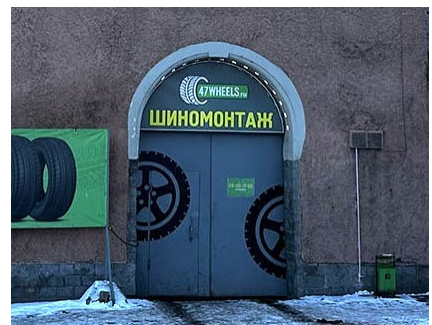
С-З фасад. Арка входа
