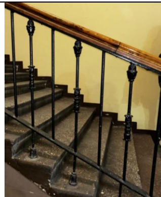
Лестница между С-З и Ю-В объемами. Фрагмент ограждения
