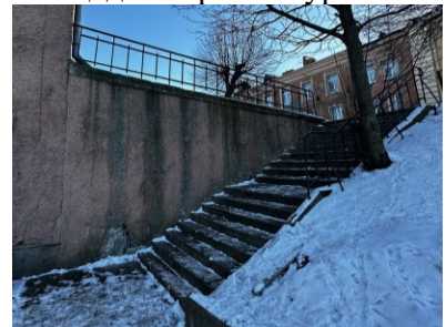
С-З торцевой фасад. Подпорная стена площадки верхнего уровня
