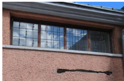
Подоконный пояс. Ю-З фасад С-З объема
