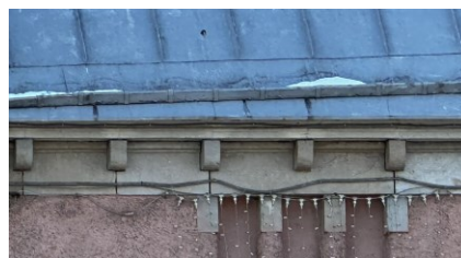
Венчающий карниз. Ю-В фасад
