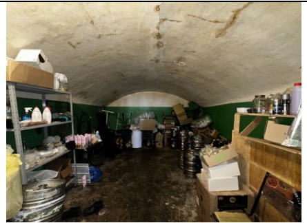
1-ый этаж. Ю-З часть С-З объема. Сводчатое перекрытие
