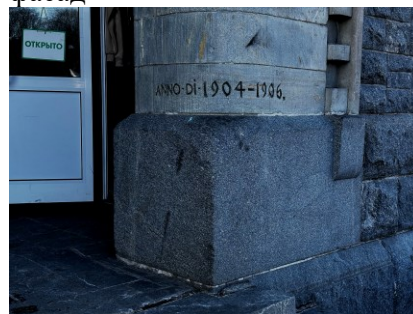
Правая пята арки портала. Ю-В фасад
