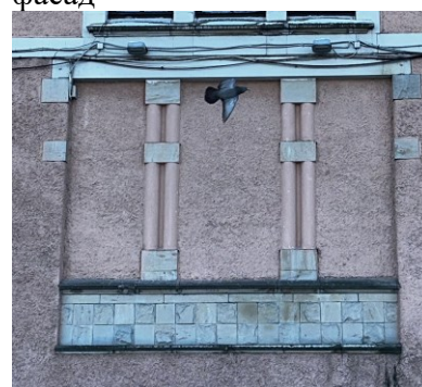
Проемы 1-го яруса. Ризалиты Ю-В входной зоны (С-В и Ю-З фасады)
