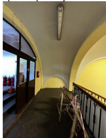
2-ой этаж. Между Ю-В и С-3 объемами. Арка
