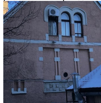
Проемы правого ризалита. Ю-З фасад
