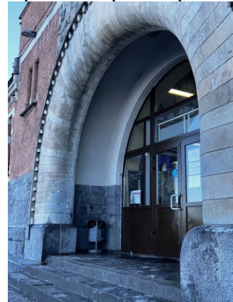
С-В фасад. Портал бокового входа. Арка портала с заплечиками
