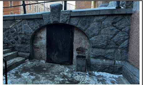
Ю-В стена нижнего яруса Ю-3 части С-3 объема. Арка входа в помещения, расположенные под площадкой верхнего уровня
