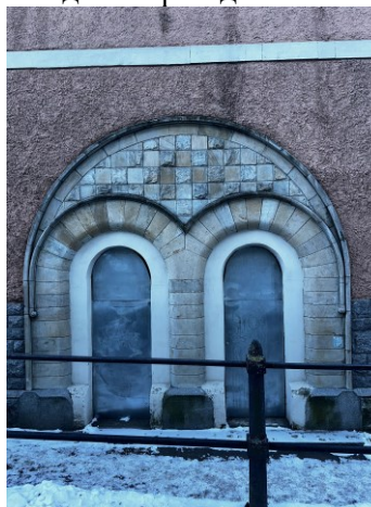
Входы. Средний ризалит Ю-В фасада
