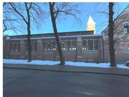
Правая часть Ю-3 фасада. Ю-В объем
