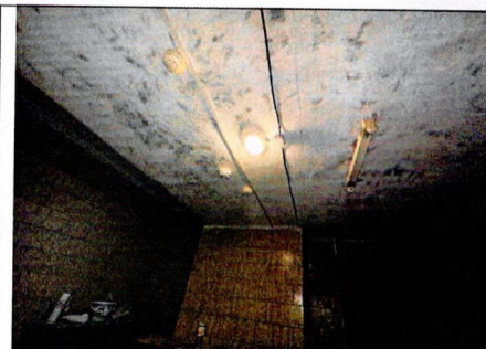
Подвал. Помещение в С-В исторической пристройке от 1934 г. Плоское перекрытие, кирпичные стены
