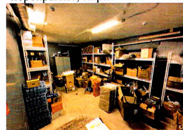
Подвал. Помещение в С-В части исторического объема. Плоское перекрытие, кирпичные стены
