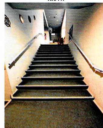
1-ый этаж. Лестница ЛК-2 в южной части
