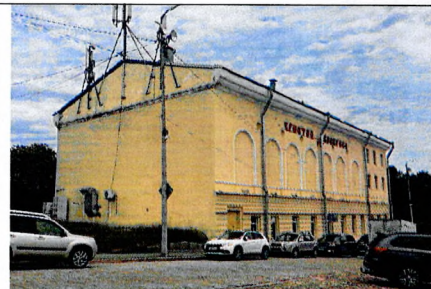
Общий вид здания с юга
