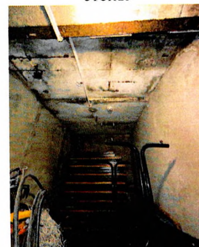
Подвал. Помещение в С-В исторической пристройке от 1934 г.. Плоское перекрытие, кирпичные стены
