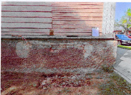
Фрагмент цоколя южного фасада
