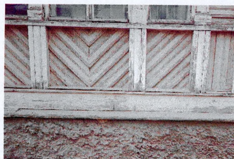
Вертикальные деревянные стойки в подоконном пространстве
