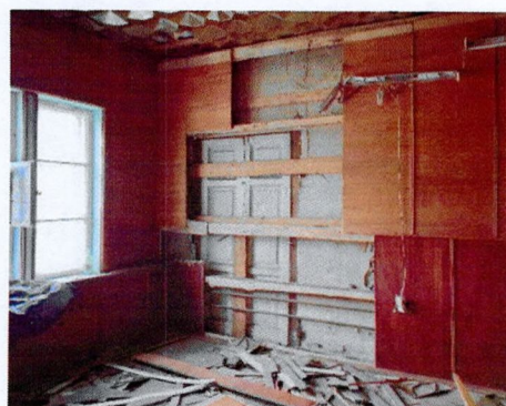
Зашитый дверной проем наружной стены юго-западного дворового фасада. Вид из интерьера
