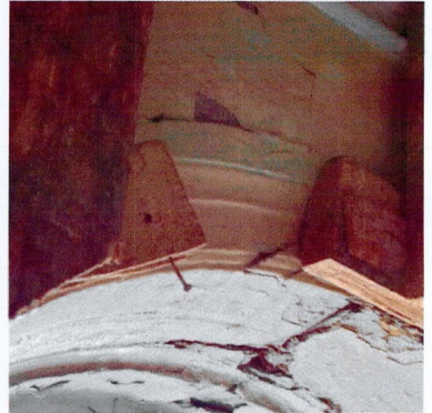
Фрагмент деревянного профилированного оконного наличника
