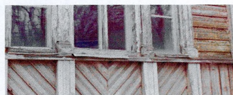
Деревянная подоконная тяга
