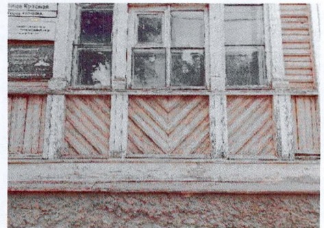
Фрагмент отделки лицевого фасада деревянной профилированной доской
