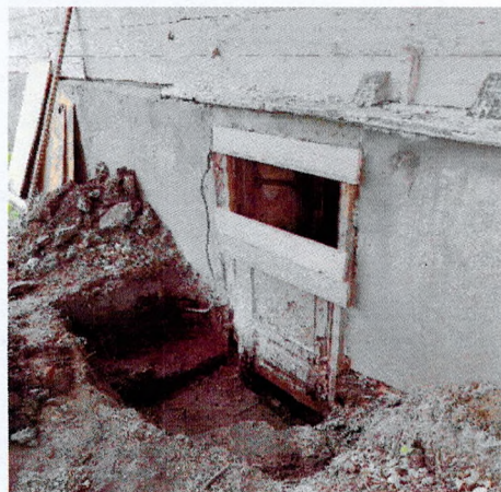
Дверной проем в цоколь. Северо-западный дворовой фасад
