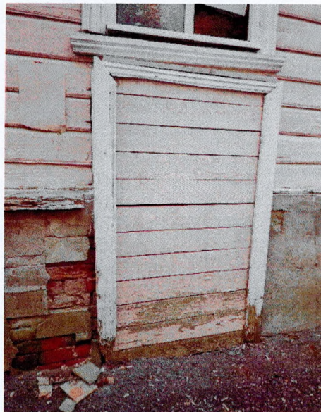
Защитый дверной проем. Северо-восточный дворовой фасад
