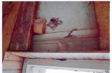
Фрагмент деревянного профилированного оконного наличника
