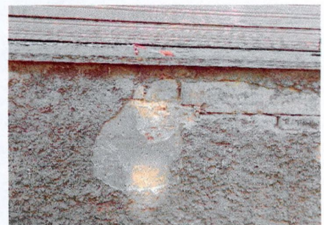
Фрагмент цоколя дворового фасада
