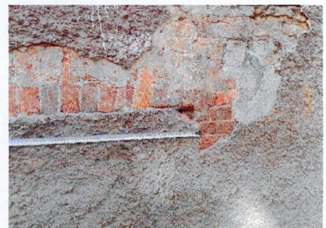
Фрагмент цоколя дворового фасада
