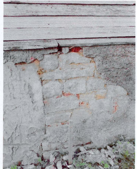
Фрагмент цоколя дворового фасада
