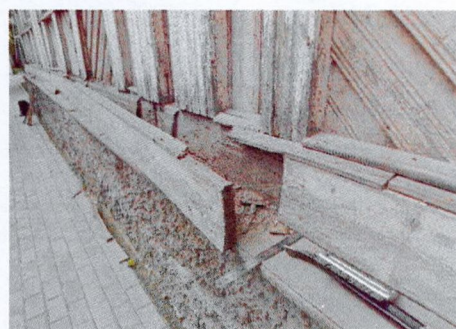
Фрагмент деревянного профилированного пояса над каменным цоколем
