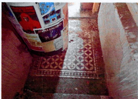
Отделки пола площадок главной лестницы (керамическая плитка)
