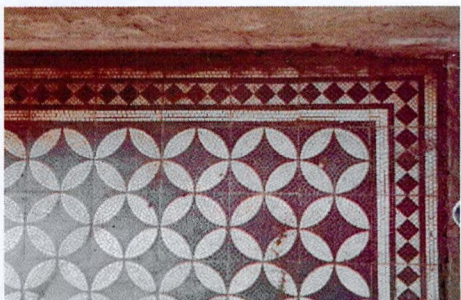
Отделки пола площадок главной лестницы (керамическая плитка)
