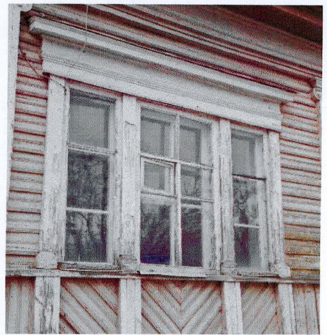
Оконный проем с заполнением. Лицевой фасад
