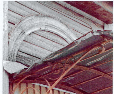
Деревянный арочный сандрик
