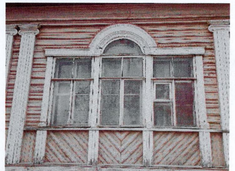
Оконный проем с заполнением. Лицевой фасад
