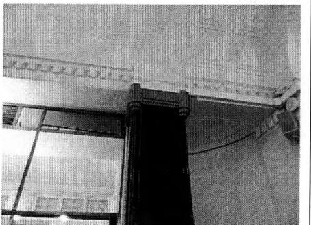
стойки по периметру зала между пилонами – исторические местоположение, габариты, конфигурация, конструкция (верхняя часть остеклена) материал (дерево, переплеты остекления – металлические), рисунок;
