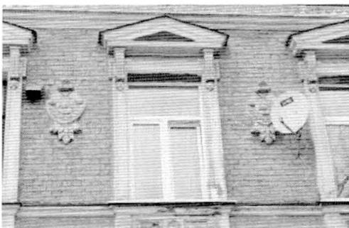
фронтоны лучковой, треугольной и прямоугольной формы на резных изогнутых консолях профилированный карниз
