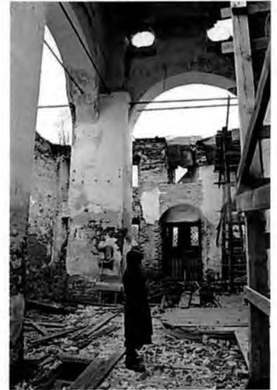
цилиндрический каменный свод второго этажа трапезной с опиранием на столбы и стены (не сохранился);
